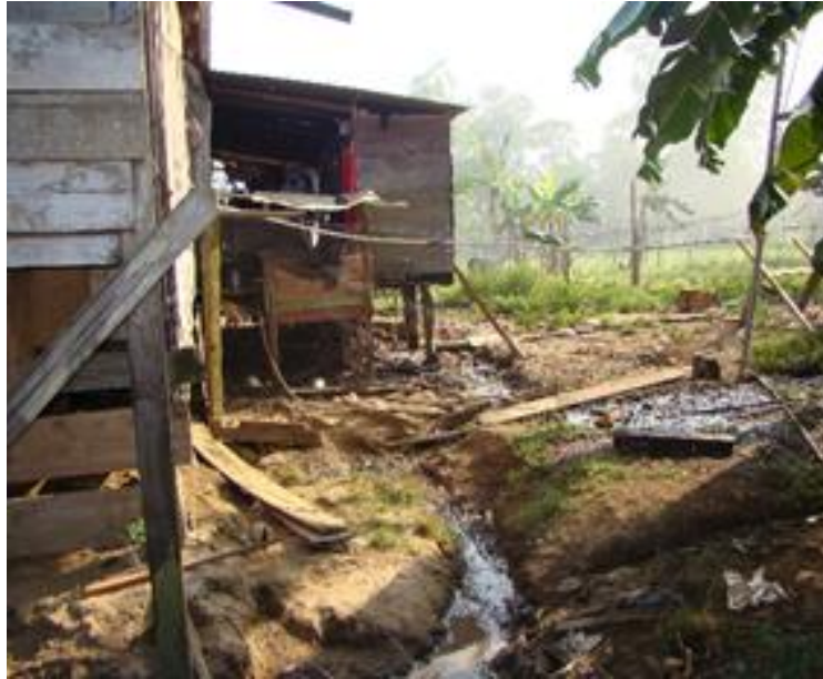
Figura 6. Sistema de aguas residuales y aguas grises cercanas al pozo de agua. Fuente: Pino y Zúñiga (2017a). Factibilidad del recurso hídrico para abastecer de agua potable a través de un acueducto comunal para la comunidad de Los Ángeles; distrito La Cureña, cantón de Sarapiquí. Programa de Regionalización Universitaria.
