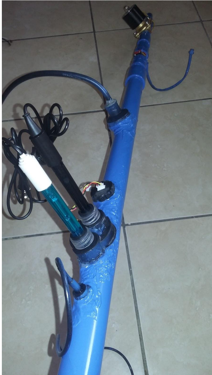
Figura 35. Adaptación de sensores a la tubería de la salida del tanque.
