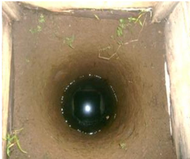
Figura 4. Parte interior de un pozo excavado y sin revestimiento.
