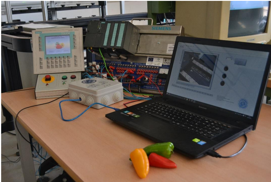
Figura 5.10. Zona de control y supervisión
