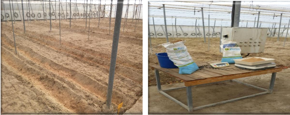
Figura 8. Apertura de carillas en el sector norte del invernadero para la aplicación de BioFence® y pesada de este mismo producto para su posterior aplicación.
