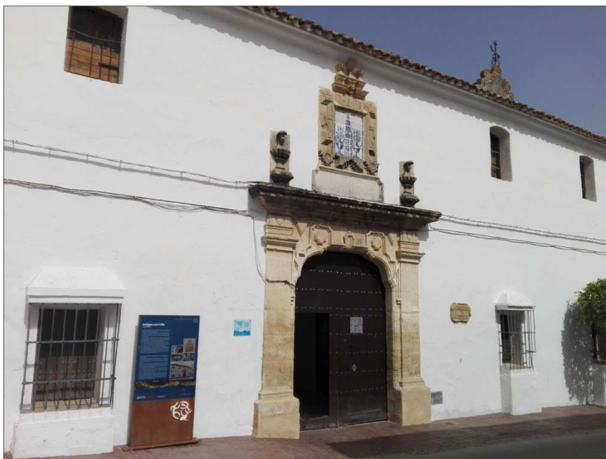
Fig. 3: Fachada principal C/ Veracruz. Foto propia.
