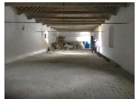
Fig. 6: Nave lateral planta alta, actualmente sin uso específico. Foto Propia
