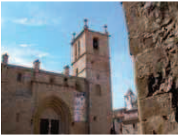
Fig. 5: Posicionamiento de estación total en torre cercana. Fuente: Propia.
