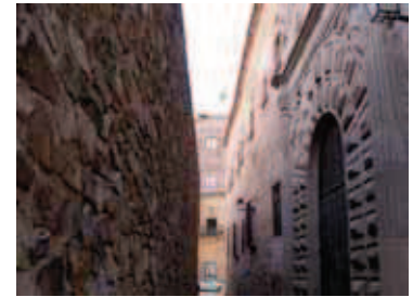
Fig. 2: Superficie irregular de una fachada de mampostería en Cáceres. Fuente: Propia.
