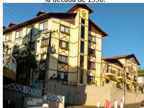
Figura 11: Hotel Tirolesa después de reforma en el final de la década de 1990.
