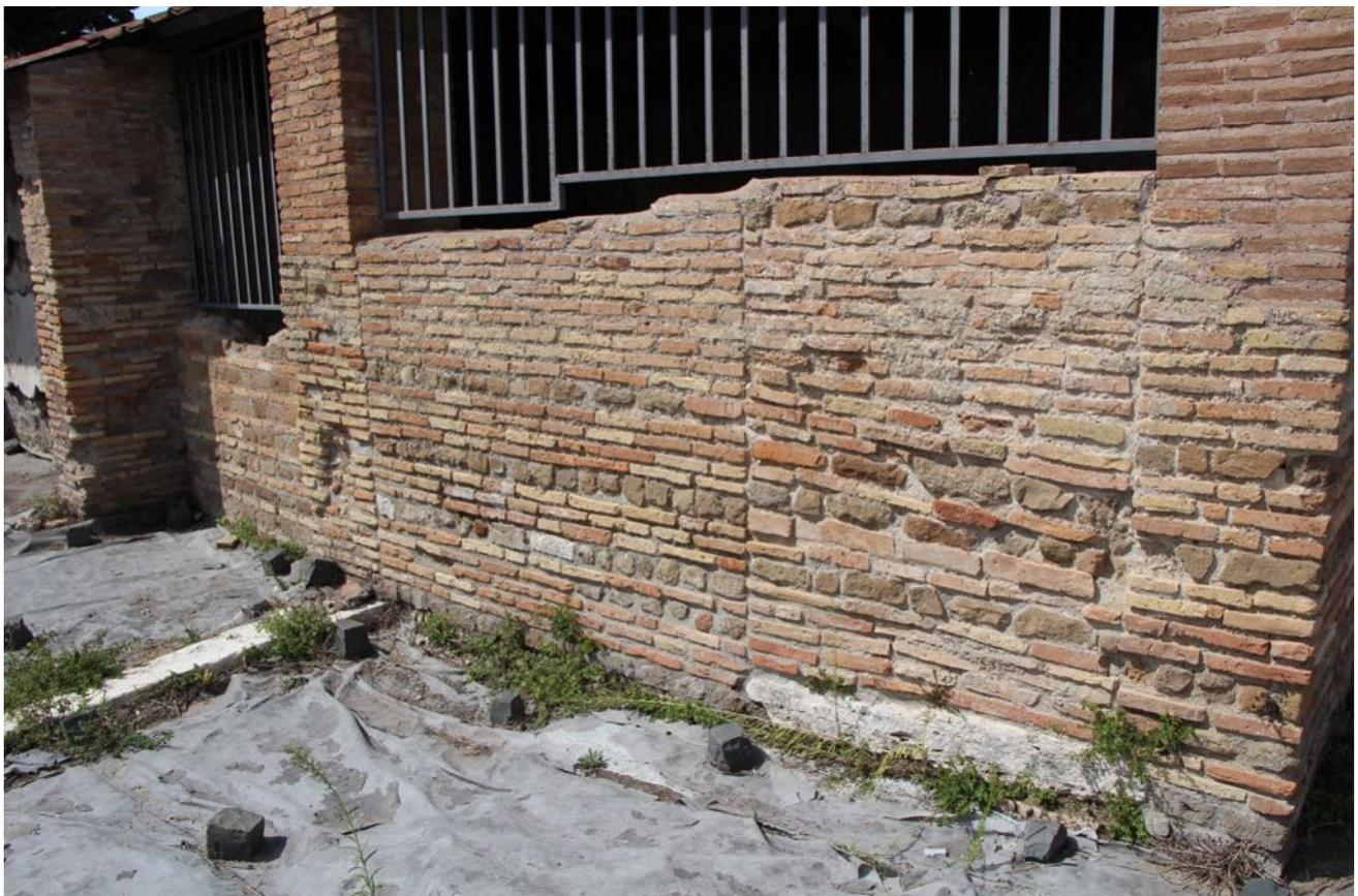
Fig. 57 – Veduta del muro in opera listata realizzato al momento dell'installazione del Mitreo delle Pareti Dipinte, a chiudere gli intercolumni tra i pilastri laterizi sul lato occidentale (A. Melega).
