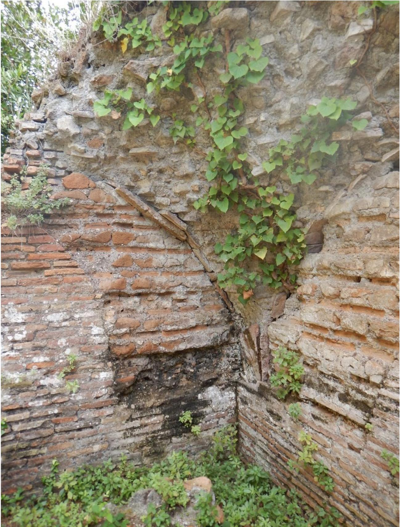
Fig. 10 - Particolare dell'angolo sud-occidentale dello *spelaeum* del Mitreo di *Fructosus*, in cui si po' notare la traccia della volta più stretta e bassa, mai realizzata, in favore di una più larga e leggera; si noti la sarcitura in opera listata (A. Melega).
