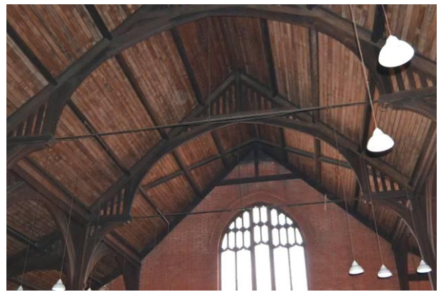
(d) All Saints (1913), Palmerston North - Rafters roof
