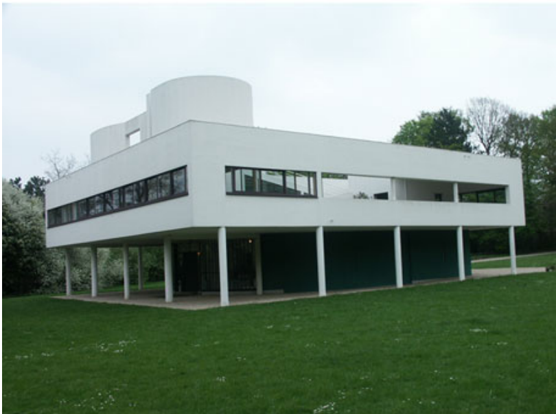
Fig. 3a-b - La Villa Savoye di Poissy presso Parigi negli anni Sessanta, abbandonata e ridotta in pessime condizioni, e nel suo stato attuale, perfettamente ripristinata dopo una folta serie d'interventi affiancati da una manutenzione stagionale (L. Benevolo, Storia dell'architettura moderna , Laterza, Bari 1960, p. 619 e foto dell'autore).
