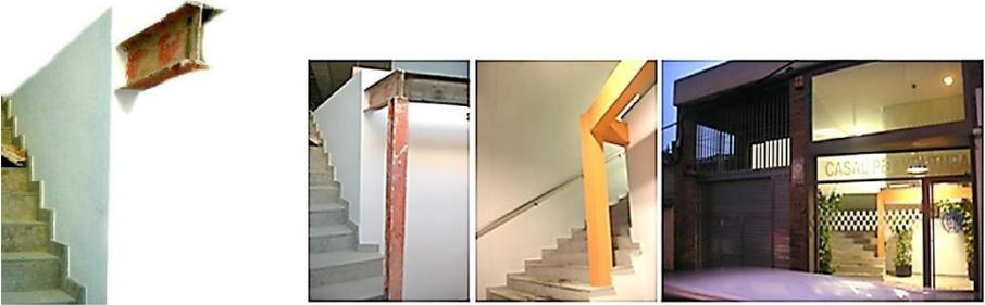
*Imagen 5.* La biga sobresalía entre el techo de la planta baja y el suelo de la primera planta y conservaba manchas de color naranja de la pintura antióxido, por eso resaltaba en la superficie blanca de la pared.
