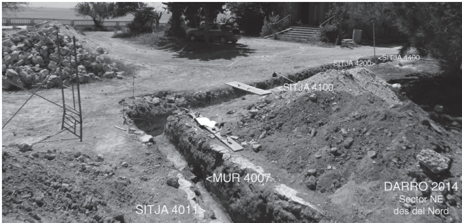
Fig. 8 - Detall de la rasa oberta en 2014 al cim del turó, concretament de l'indret on fa el colze. Foto: J. Amorós.
