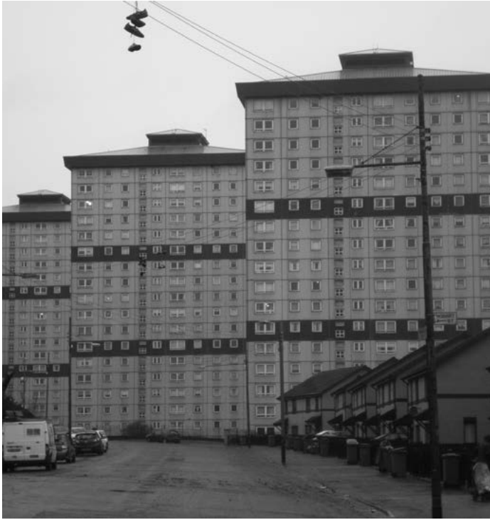
De Westercommon flats zijn de grote blikvanger in het westen van Possilpark, dat verder voornamelijk uit laagbouw bestaat.
