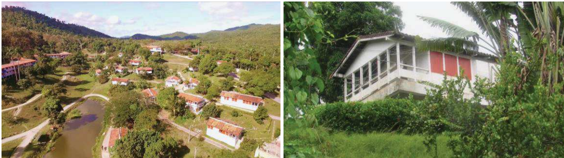
Figura 4: Vista panorámica de la comunidad y vivienda unifamiliar sobre pilotes. Fuente: Colectivo de autores.
