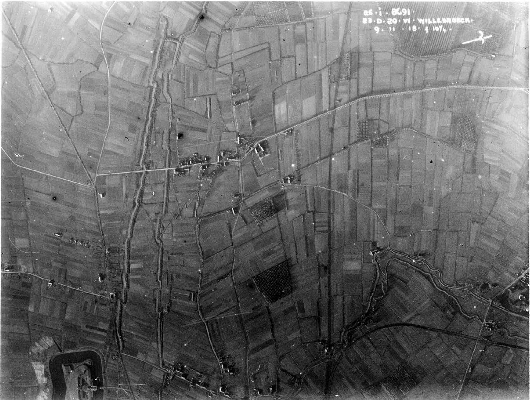
Het fort van Breendonk in november 1918, voor de A12 het landschap doorsneet. Het gebied is nog volledig agrarisch, de bebouwing van Willebroek, helemaal onder in beeld, is nog beperkt. Verschillende loopgraaflijnen van de Duitse Südabschnitt zijn zichtbaar.
