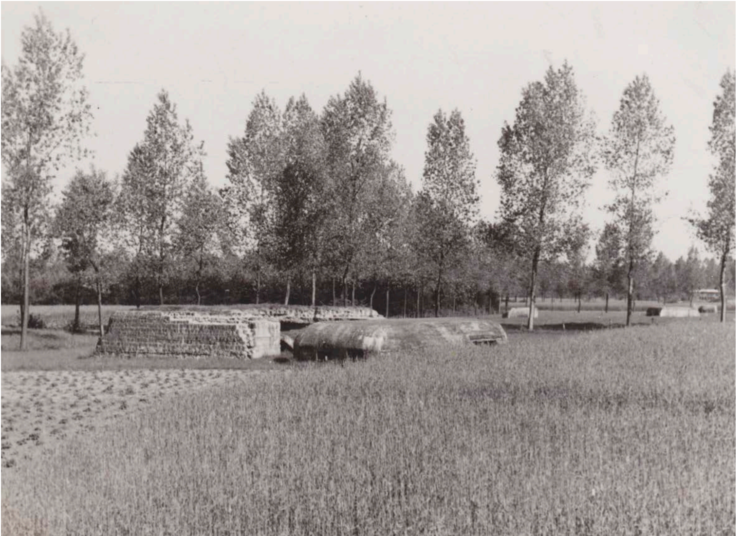
Foto genomen ten noorden van Antwerpen, vermoedelijk tijdens de Tweede Wereldoorlog. Op de akkers zijn nog duidelijk Duitse bunkers uit 1916–1917 zichtbaar. Let op het verschil met de Belgische bunker links in beeld, gebouwd in 1914 door de firma Bolsée in opdracht van het Belgische leger en te herkennen aan de kasseien.
