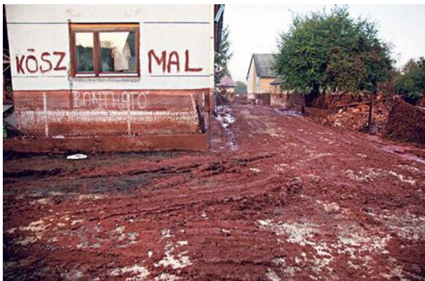
写 25. MAL Zrt における被害
