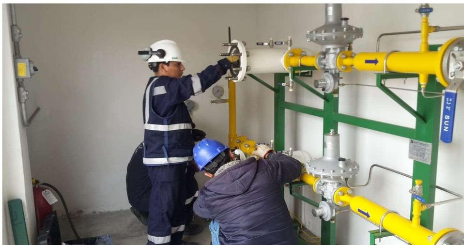
*Figura 4.- Servicio de mantenimiento de la red de Gas Natural. Elaboración propia*
