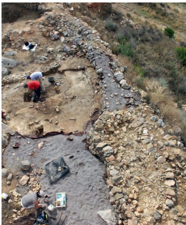
Figura 22. Trabajos de recuperación y consolidación de la muralla en la campaña de 2007.
