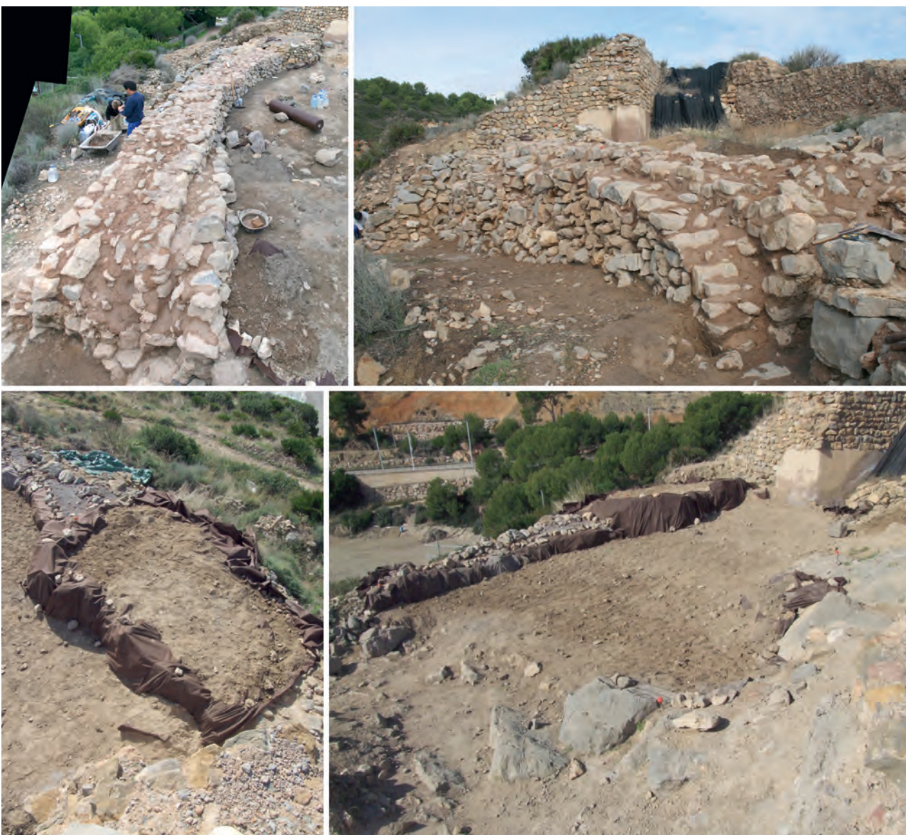
Figura 19. Trabajos de consolidación y protección preventiva en la campaña de 2008.
