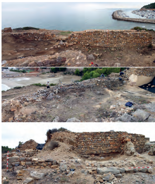
Figura 14. Diversas vistas de los trabajos de limpieza y consolidación de la campaña de 2005.
