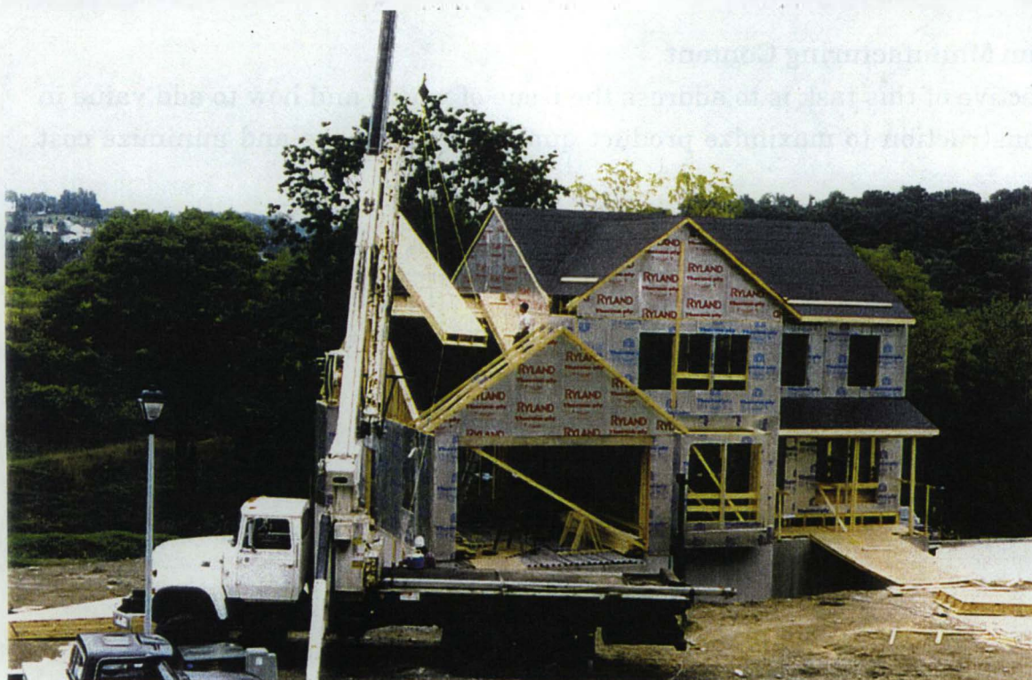
Figure 6-4, MIT Roof System Construction on IBACoS Lab Home
