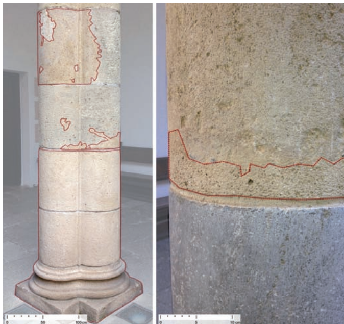
Figura 2. Detalles de piedra calcarenita bioclástica, ubicada en la columnata del Patio de la Capilla del Hospital Real de Granada (s. XV) y piedra artificial porosa restauradora en las faltas de soporte. Las líneas quebradas rojas resaltan la piedra artificial porosa añadida como mortero de restauración.
