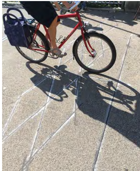
Photo 1 : Poste de comptage automatique sur le pont Kreuzackerbrücke à Soleure
