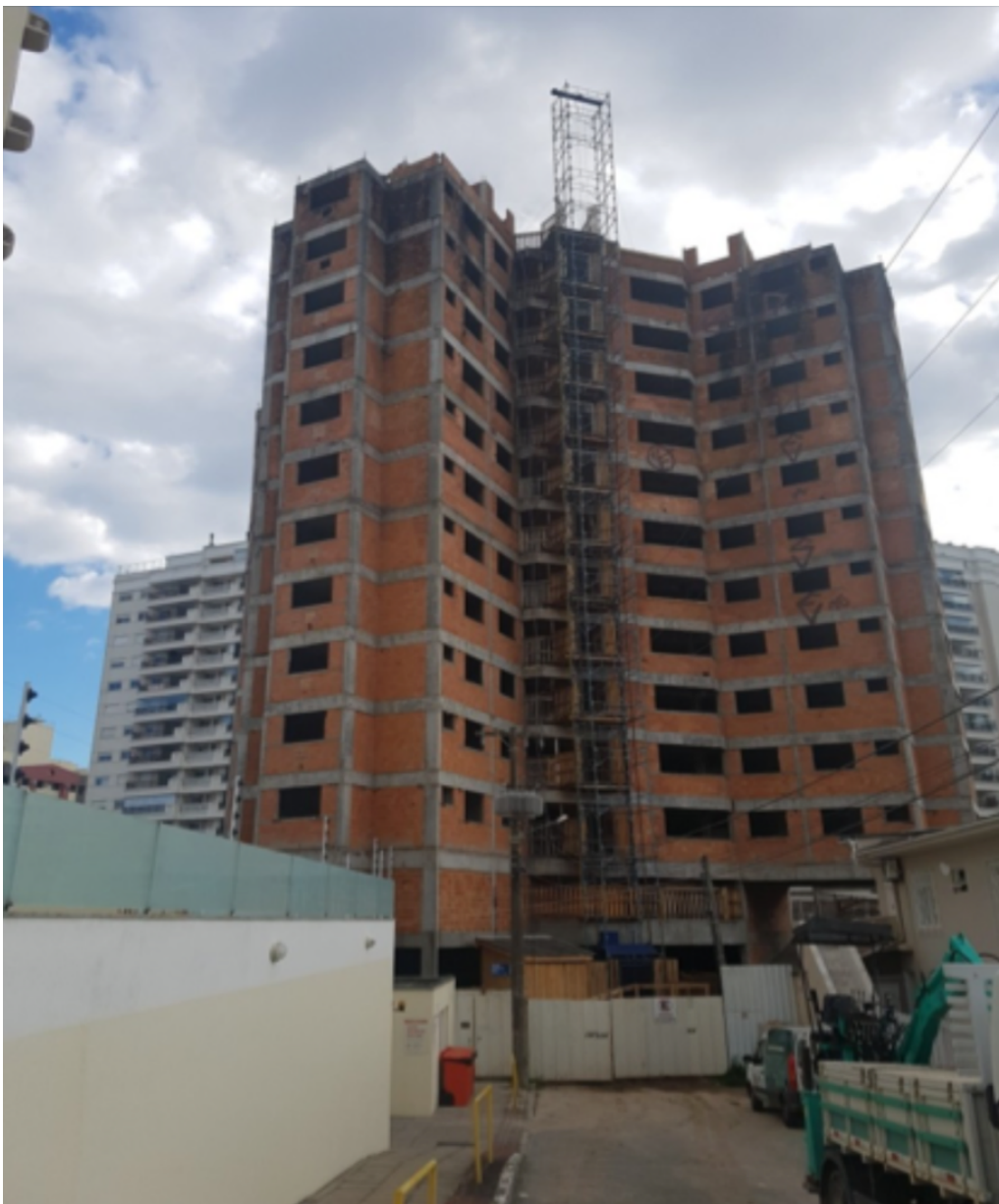
Figura 18 – Situação da obra ao início do estudo
