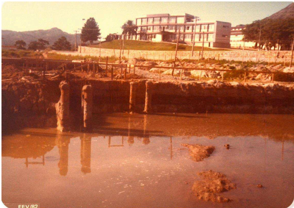
Figura 9 – Imagem de fevereiro de 1982 apresenta obra ainda em fase de construção das fundações da edificação
