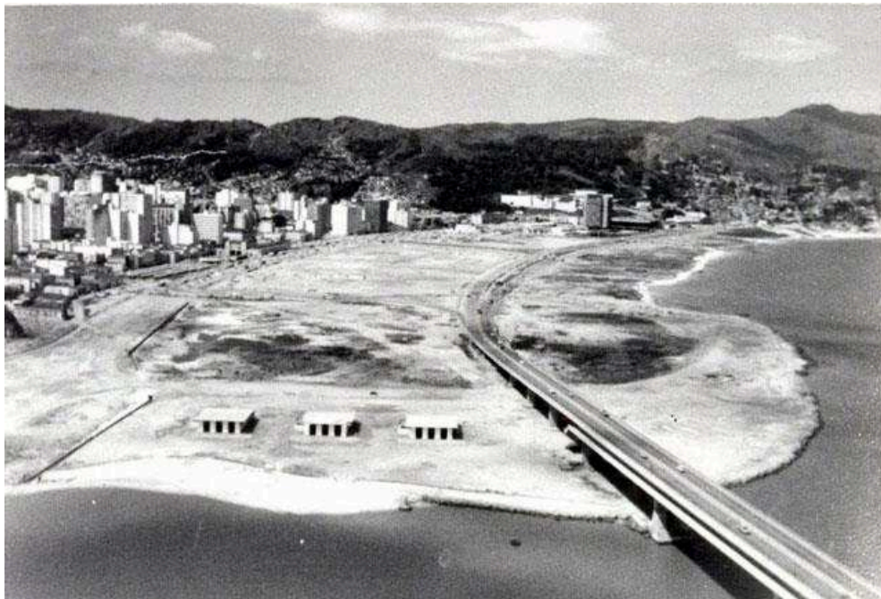
Fonte: Ponte Hercílio Luz (2017)
