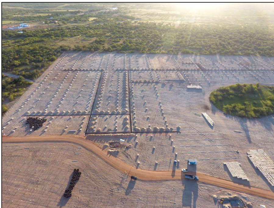
Figura 2.17 - Valas abertas em usina fotovoltaica
