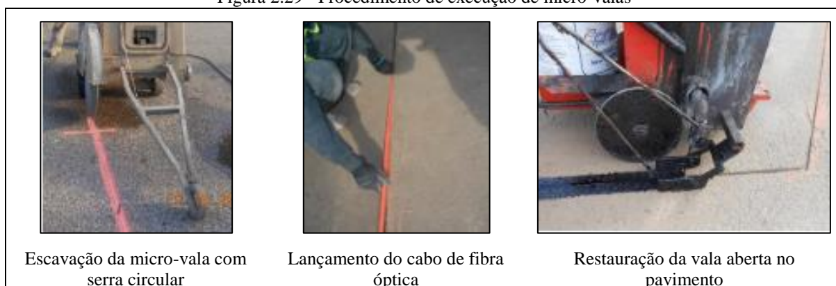
Figura 2.29 - Procedimento de execução de micro-valas
