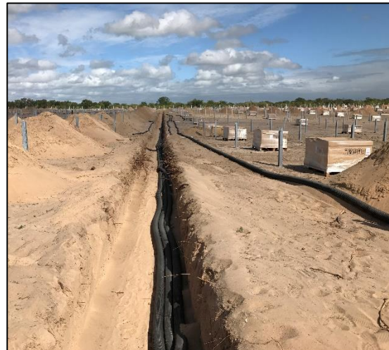
Figura 2.11 – Eletrodutos posicionados em vala escavada pelo método convencional
