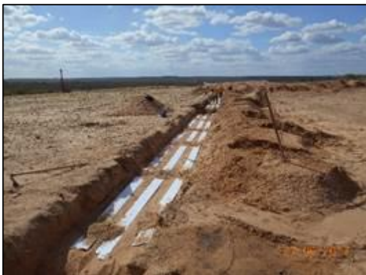
Figura 2.12 - Instalação da proteção mecânica em vala escavada pelo método convencional
