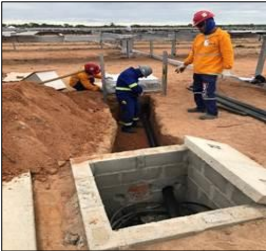
Figura 2.10 - Lançamento de eletrodutos no método convencional
