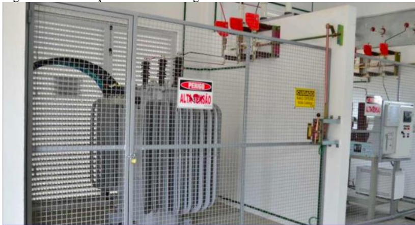
Figura 3 - Subestação interna ou abrigada
