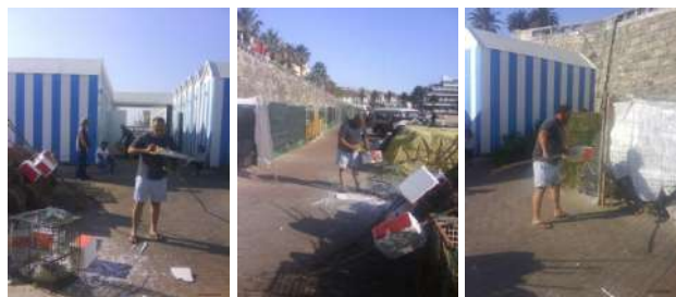
Figura 27 – Montagem de bóias nas proximidades dos Cacifos.
