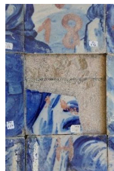
Figura 27. Identificação de um fragmento graças à montagem do painel. Foto: Cátia Q. (04/01/17).
