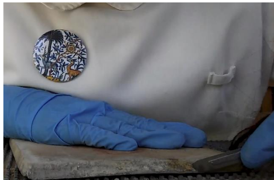
Figuras 66 e 67. Remoção de argamassas com bisturi. Foto: Cátia Q. (04/05/18)
