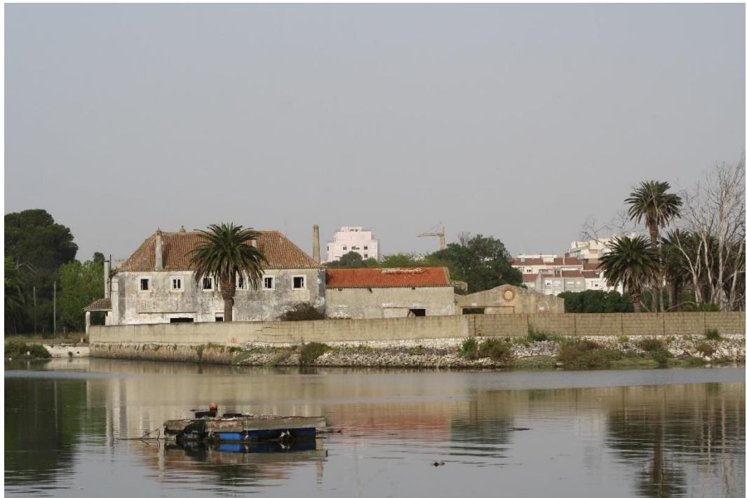
Fotografias – Vista Este da Quinta Braamcamp, Pré-incêndio, 2009
