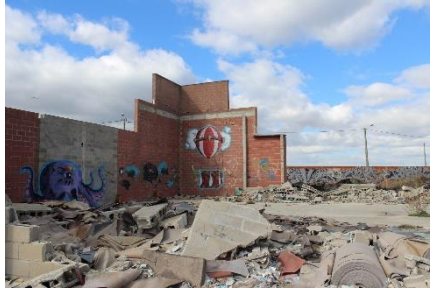
71 e 72. Estado atual da SNC – terreno absoluto, paredes soltas e restos de materiais pertencentes às antigas fábricas de cortiças. Fotografias da autora
