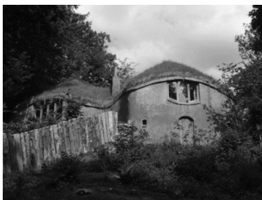
22 e 23. Planta e Alçado Sul do infantário Steiner Nant-Y-Cwm, (1989) no País de Gales, de Christopher Day
