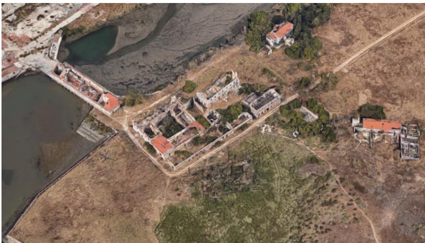
85. Atuais ruínas da estrutura edificada da Quinta de recreio
