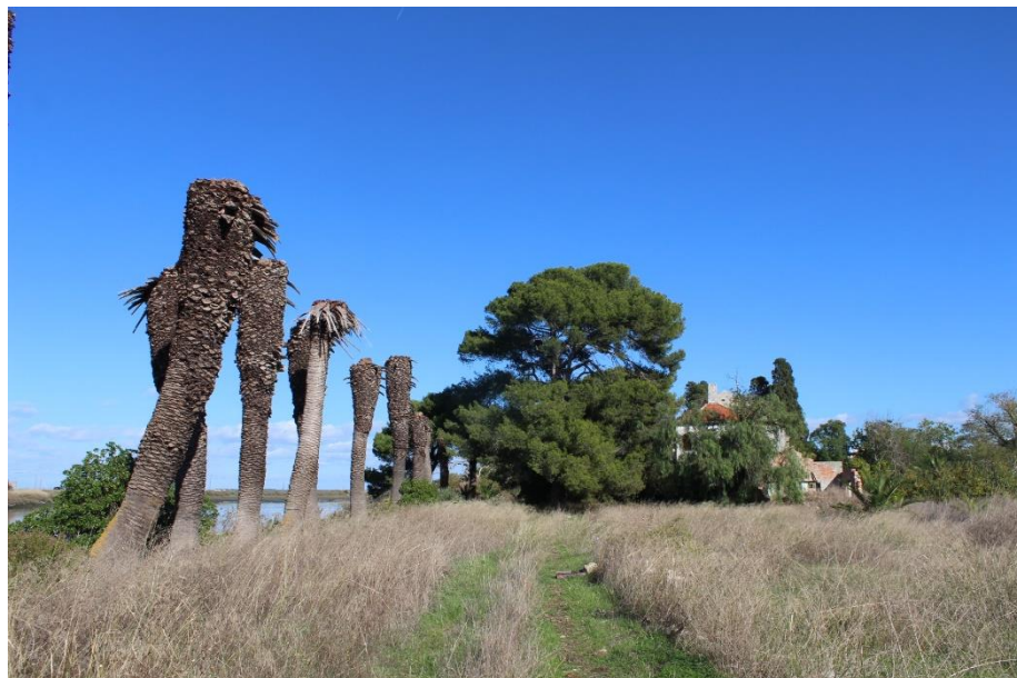
Registo Fotográfico. Imagens da autora – Estado atual da Quinta Braamcamp e envolvente – acesso ao terreno da Quinta
