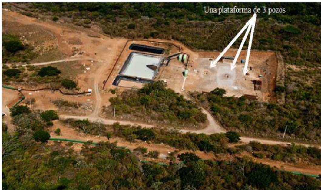
Figura 7: Plataforma con 3 contrapozos, para perforación direccional. Fotografía: Uribe (2011)
