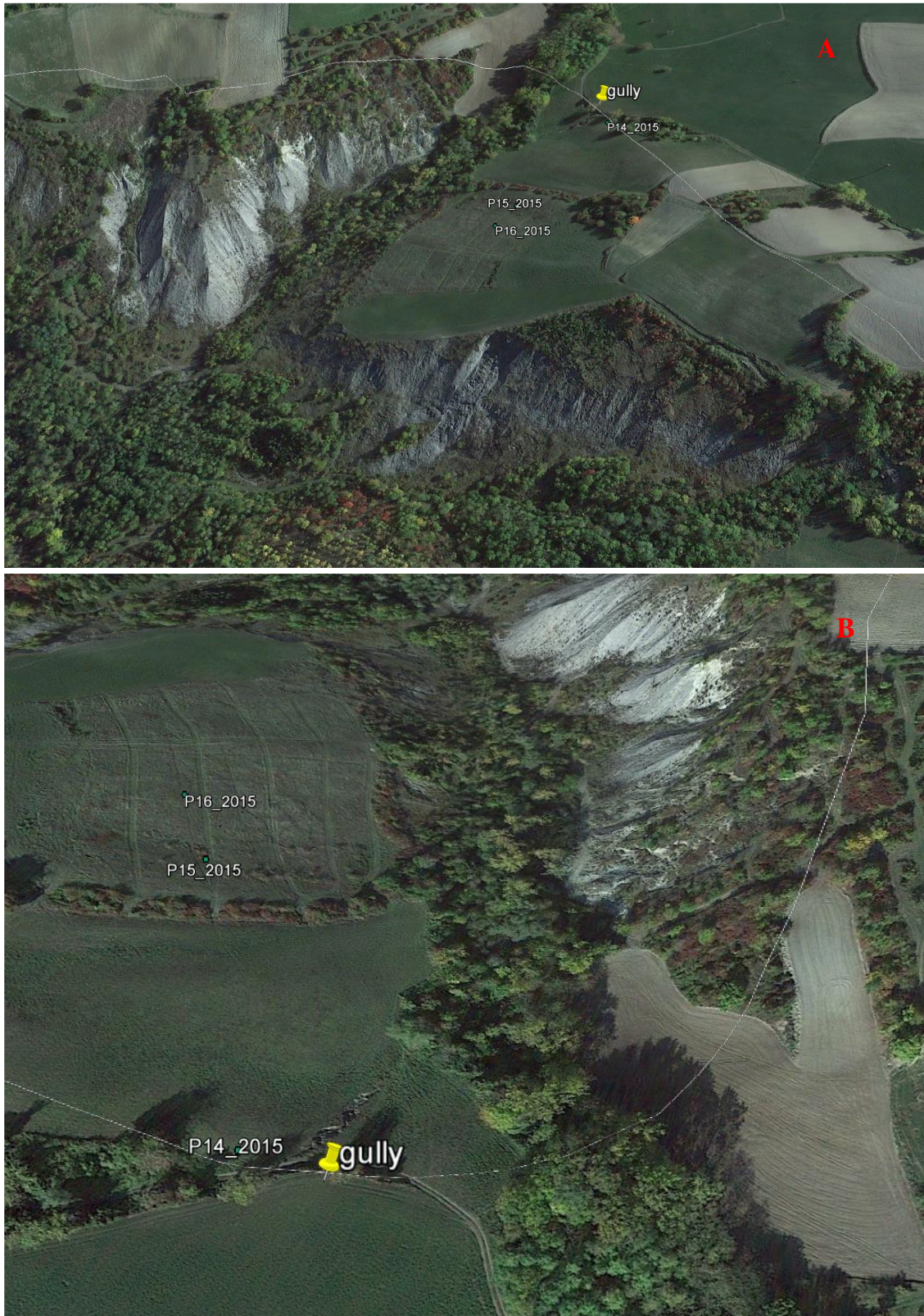
Fig. 6.11 Fenomeni di erosione in corrispondenza della formazione delle Brecce di Baiso in località di Costa Croce. Sul versante con il fianco rivolto a ovest è presente un tipico calanco classificabile di tipo A, sul versante esposto a nord, a circa 200 m, è presente erosione di tipo laminare ed evidenze di rill , è inoltre presente una piccola frana (A). Nella parte soprastante, esposta a nord-ovest, in un'area agricola incolta, è presente erosione da soliflusso a poca distanza si è generato un gully .
