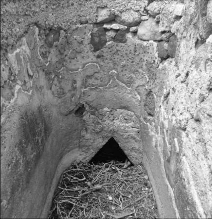
Fig. 181 - Particolare della canalizzazione sotterranea sul lato sud-ovest della cisterna 41 (foto dell'autore).
