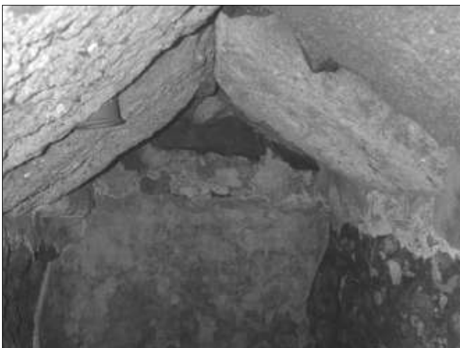
Fig. 306 - La copertura "alla cappuccina" della cisterna 37 (foto dell'autore).
