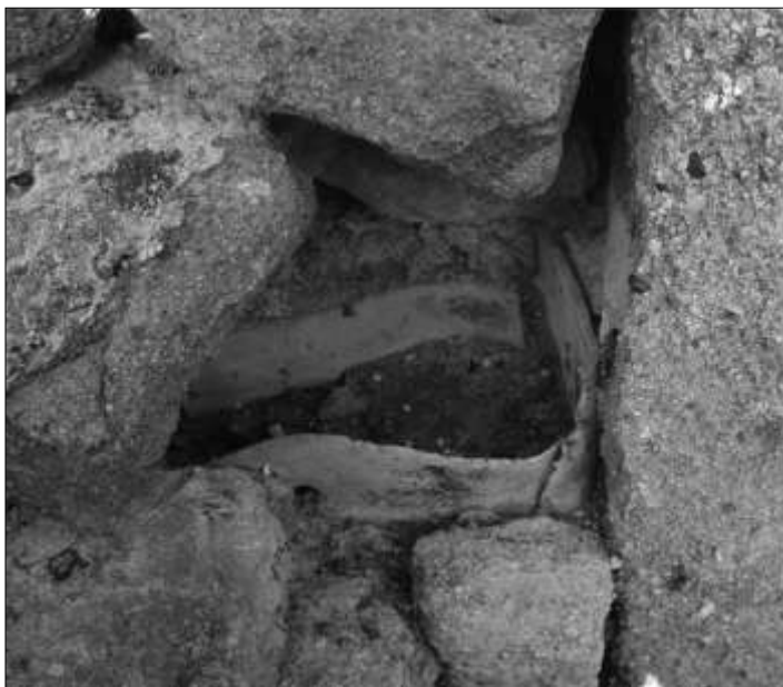
Fig. 299 - La parte iniziale della canaletta in piombo della cisterna 31 (foto dell'autore).
