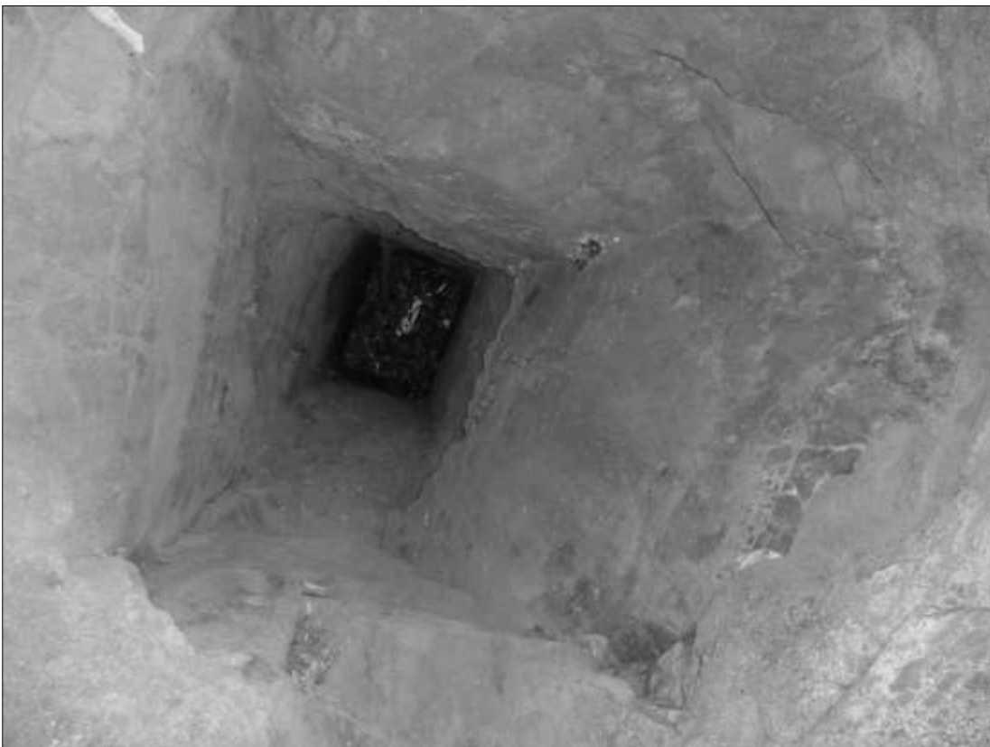
Fig. 78 - Particolare della profonda canna del pozzo, da sud (foto dell'autore).
