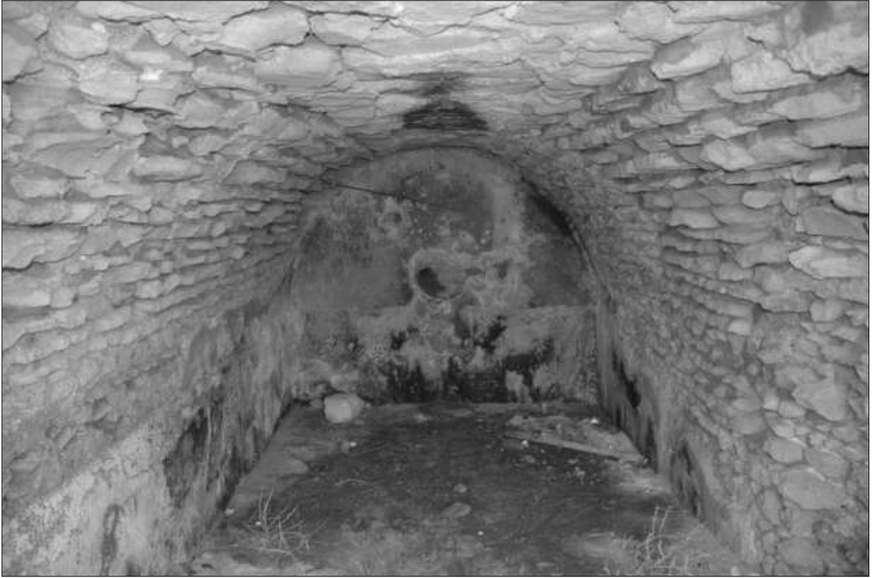
Fig. 194 - La cisterna/serbatoio 46 dall'interno, di cui si può notare la copertura a conci sovrapposti e la canaletta centrale sulla parete di fondo (foto dell'autore).
