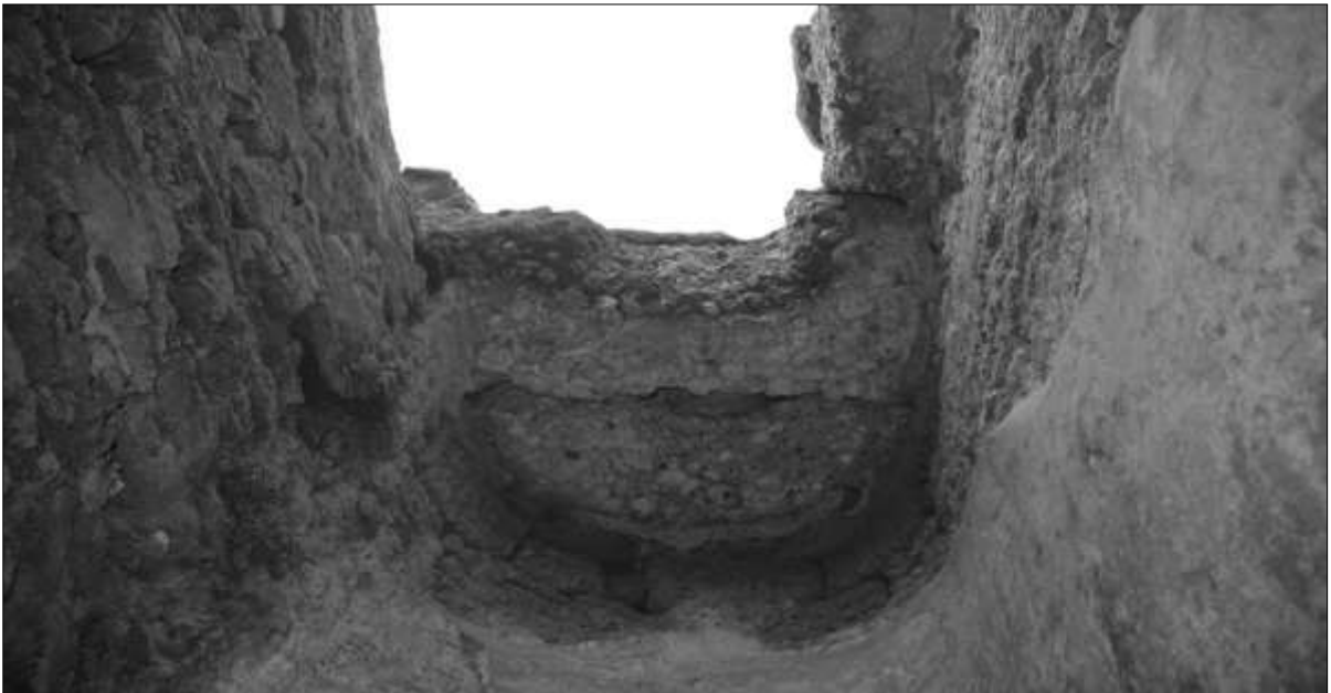
Fig. 98 - I due architravi di copertura posti sul lato breve sud, in cui è ricavato il pozzetto di attingimento circolare (foto dell'autore).
