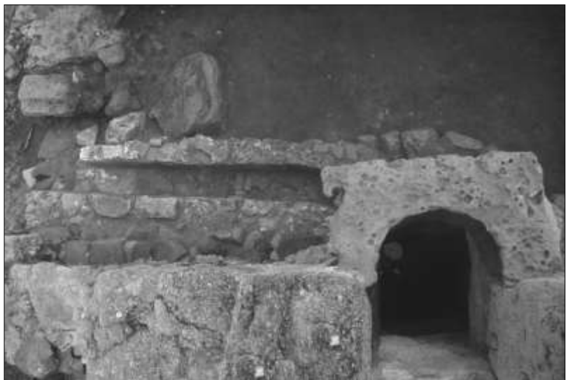
Fig. 283 - La canaletta di adduzione connessa al pozzo 7 lungo la sua parete S-E (foto dell'autore).
