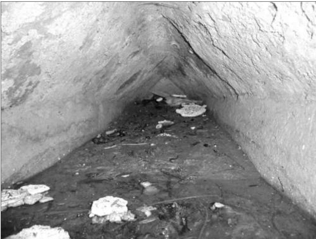
Fig. 182 - L'interno della canalizzazione della cisterna 41 (foto dell'autore).
