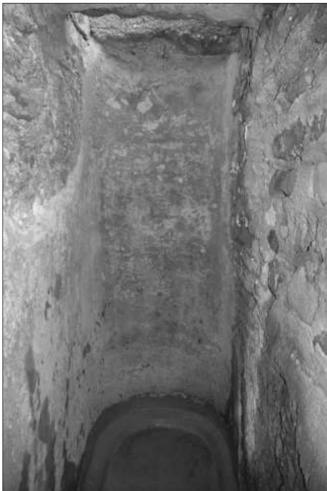
Fig. 99 - Il lato corto settentrionale: ben si nota lo zoccolo convesso di raccordo tra parete e fondo (foto dell'autore).
