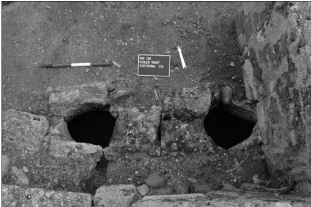
Fig. 307 - La copertura originaria della cisterna 35: lastre a doppio spiovente e i due pozzetti di attingimento ricavati su questi (foto dell'autore).
