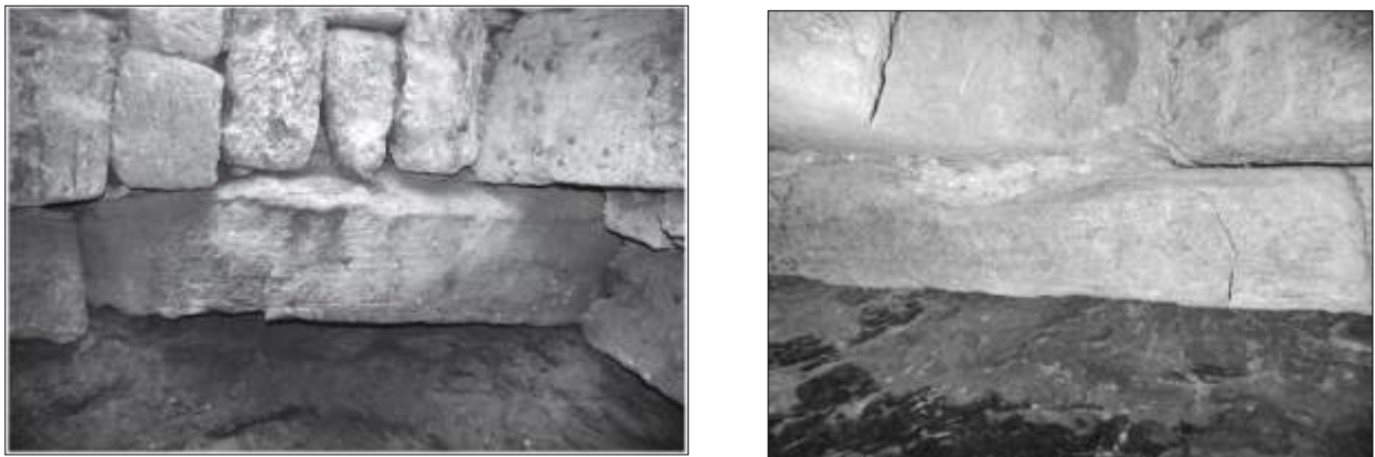
Figg. 275a, 275b - Il confronto tra le simili tecniche costruttive del pozzo 6 (a sinistra, da Savio 2014, p. 179) e della cisterna 77 (foto di M. Cardani).
