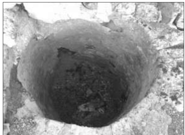
Fig. 290 - La morfologia "a cilindro" della cisterna 51 (foto dell'autore).
