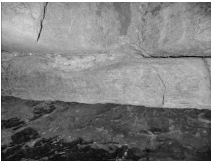
Fig. 255 - L'interno della cisterna 77: i blocchi squadrati di arenaria si impostano direttamente sulla roccia andesitica (foto di M. Cardani).
