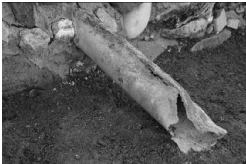
Fig. 314 - Tubazione in piombo inglobata in una struttura muraria di un vano alle pendici S-O del colle di Tanit (foto dell'autore).
