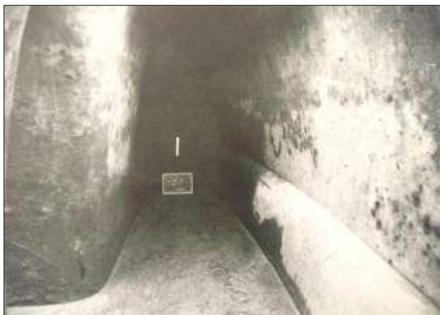
Fig. 8 - Cagliari. Cisterna di via Po (da COLAVITTI 2003, p. 21).
