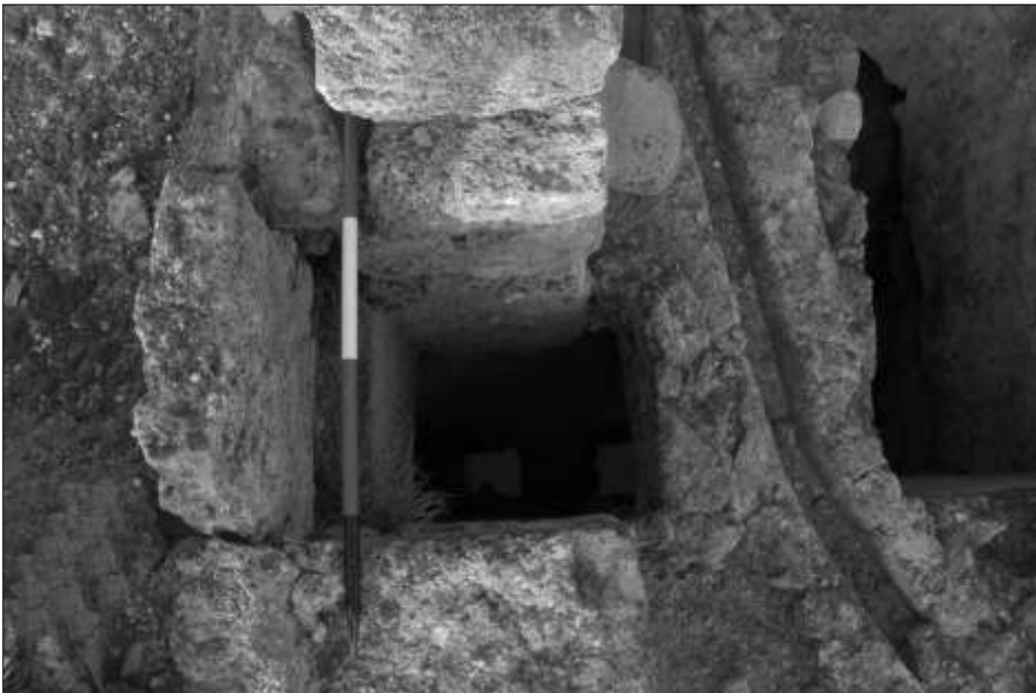
Fig. 176 - Particolare del pozzetto di attingimento della cisterna 39, collegato sotterraneamente (foto dell'autore).
