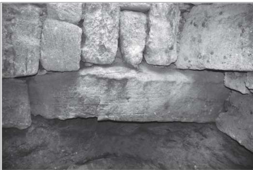
Fig. 49 - Particolare della muratura a grandi blocchi andesitici del pozzo 6 (da SAVIO 2014, p. 179).
