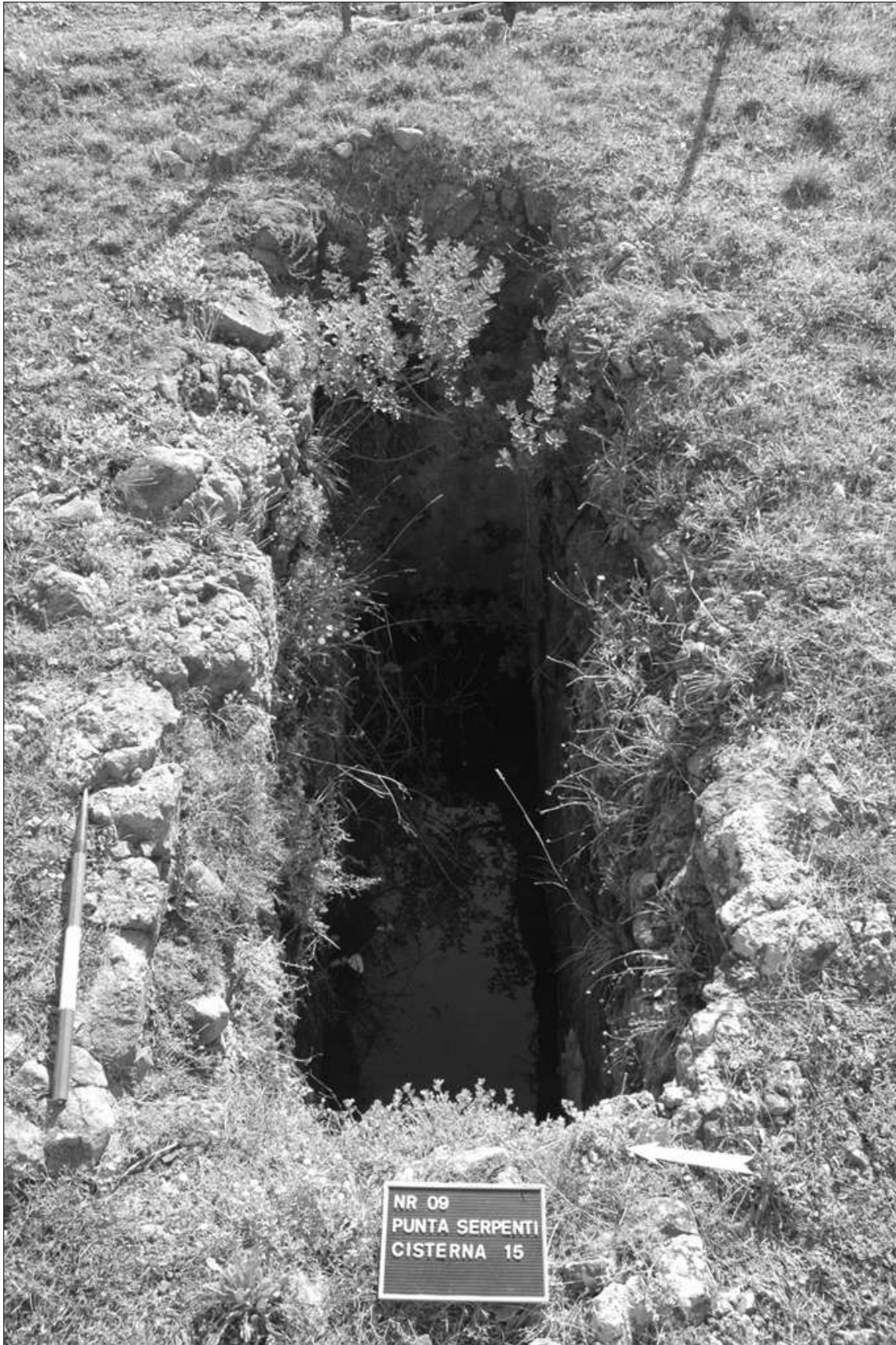
Fig. 127 - La cisterna 15 vista da ovest (foto dell'autore).
