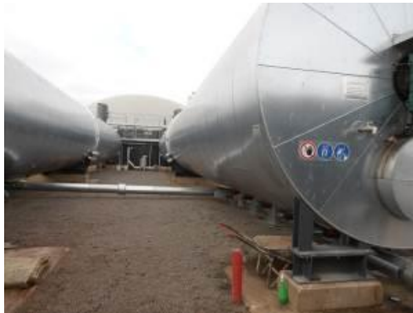
Figura 2.2-7 Digestore a flusso orizzontale
