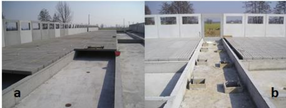
Figura 3.3-9 - tecnica di rimozione vacuum vista in fase di costruzione in una porcilaia
