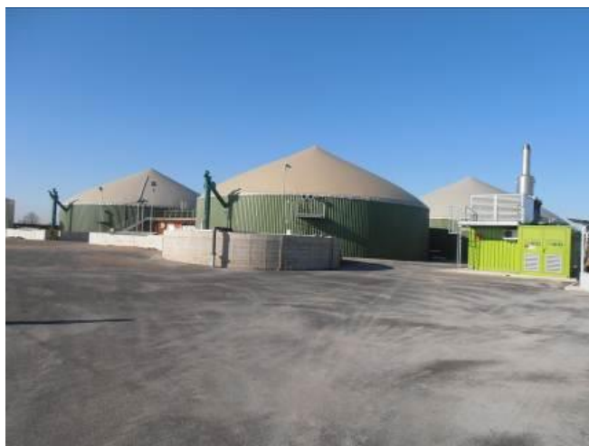
Figura 2.2-1 Impianto di biogas con due digestori primari un post-digestore
