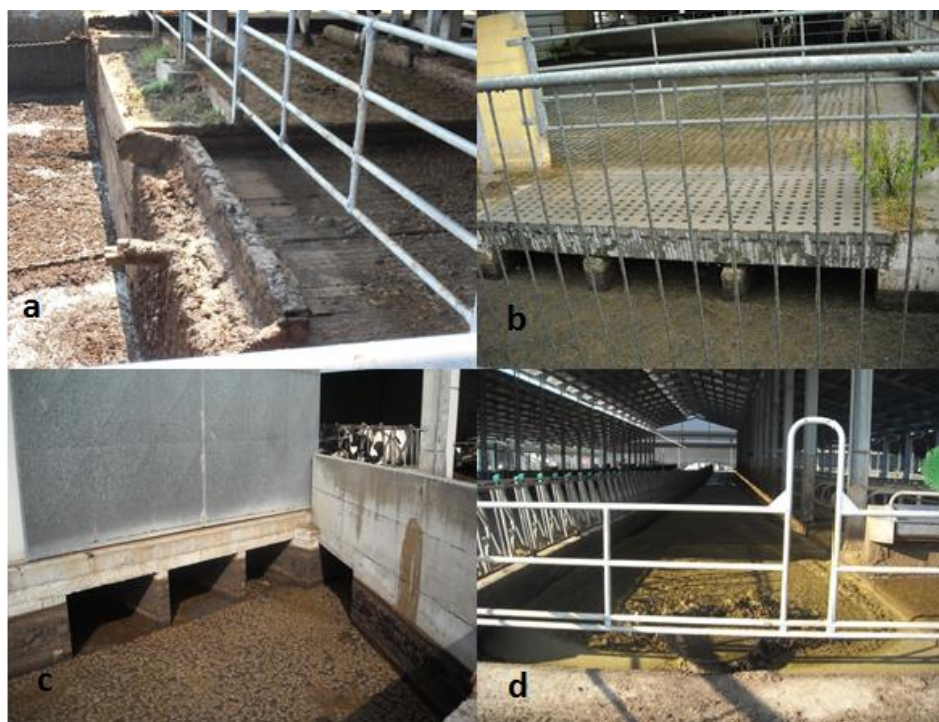
Figura 3.3-6 - tecniche di rimozione dell'effluente dalla stalla nel caso degli allevamenti di bovini da latte: (a) raschiatore su pavimento pieno; (b) fessurato con fossa sottostante; (c) ricircolo sotto fessurato; (d) flushing su pavimento pieno.
