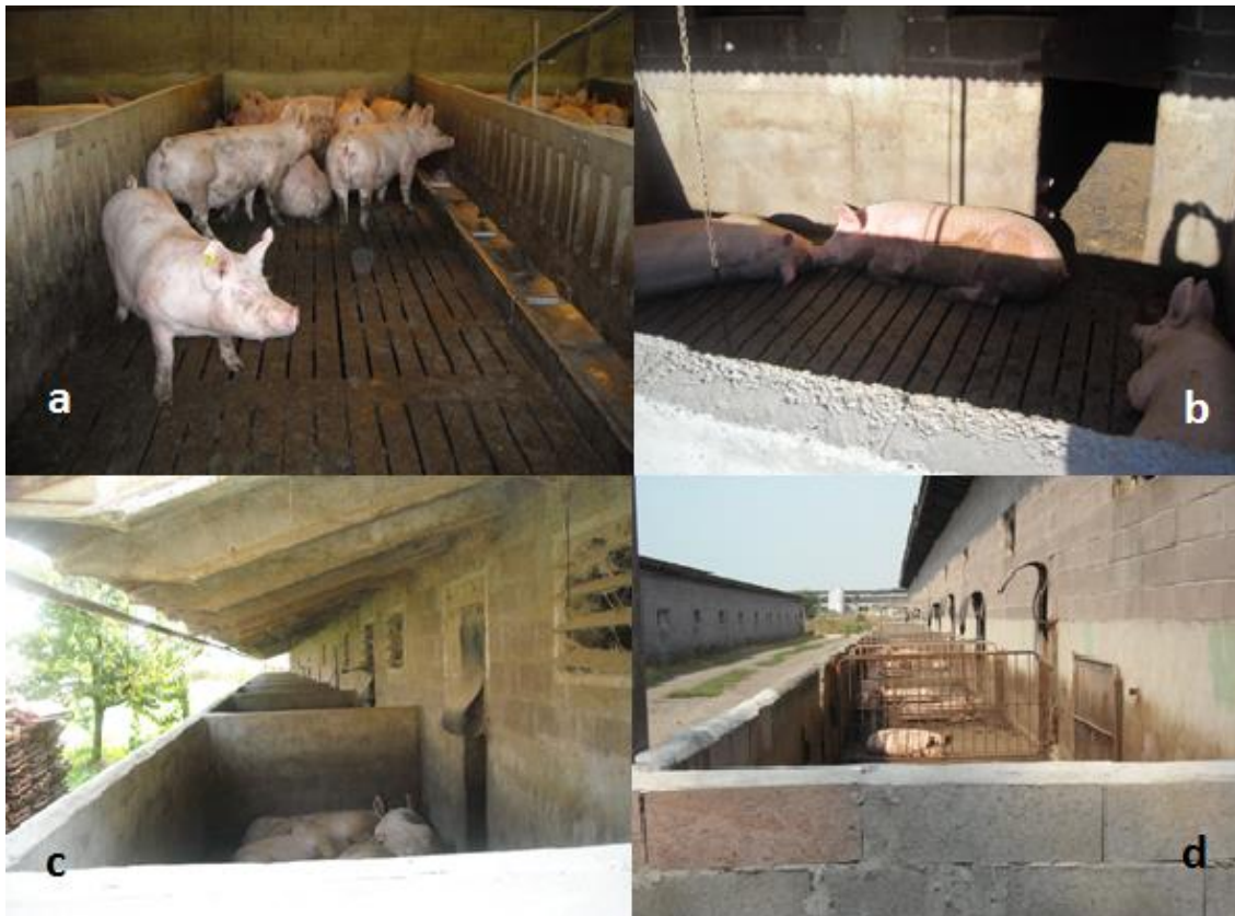
Figura 3.3-8 - tipologie di stabulazione nei reparti di magronaggio e ingrasso: box con pavimento totalmente fessurato (a); box con pavimento pieno e corsia esterna di defecazione con pavimento totalmente fessurato (b); corsia esterna coperta (c); corsia esterna scoperta (d)
