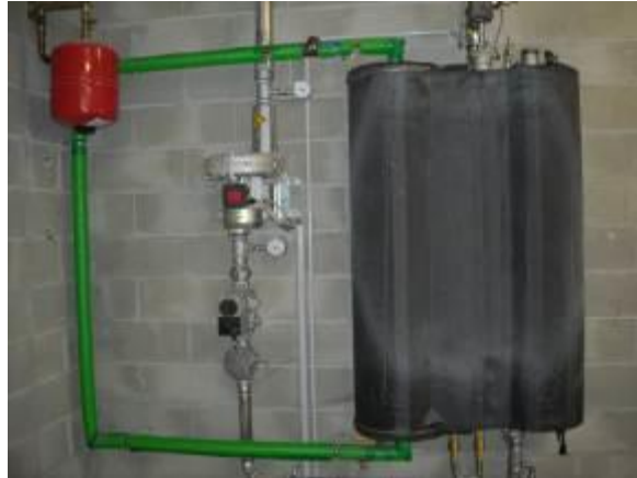
Figura 2.2-4 Filtri a carboni attivi per la rimozione dell'acido solfidrico
