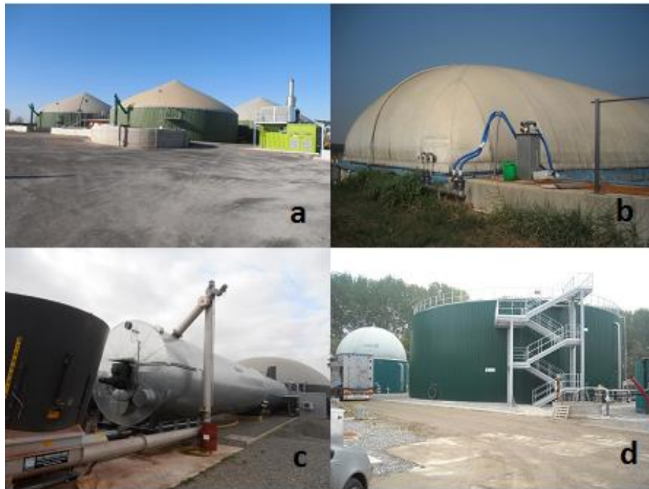
Figura 3.3-10 - Tipologie di impianti di biogas campionati: (a) impianto da 1MW alimentato con liquame suino (60%) e insilati (40%); (b) impianto semplificato da 100kW alimentato solo con liquame suino; (c) impianto da 625kW alimentato con liquame suino (10%) e insilati più sottoprodotti (90%); (d) impianto da 250kW alimentato con liquame suino concentrato (separato solido e componente ispessita da flottazione)
