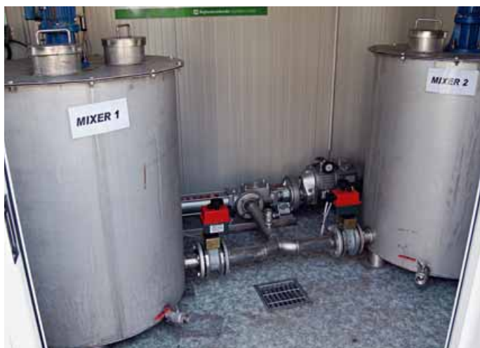
Foto 2 - Serbatoi da 0,7 \text{ m}^3 collegabili alternativamente all'interno dei quali avviene la preparazione dell'ingestato
