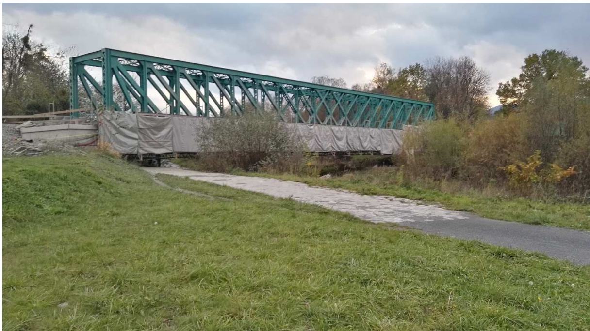
Obr. 3 Rekonstrukce mostní konstrukce v km 103,854 v roce 2018 (zdroj: autor)
