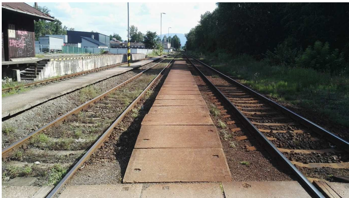
Obr. 7: Nástupiště a rampa v žst. Baška (zdroj: autor)
