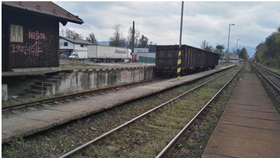
Obrázek 10: Rampa na manipulační koleji v žst. Baška (zdroj: autor)
