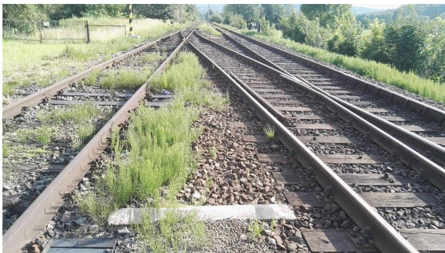
Obrázek 14: Zhlaví v žst. Pržno (zdroj: autor)
