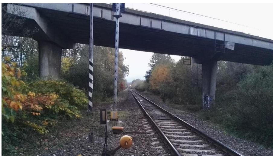
Obrázek 16: Silniční nadjezd nad tratí č. 323 (zdroj: autor)
