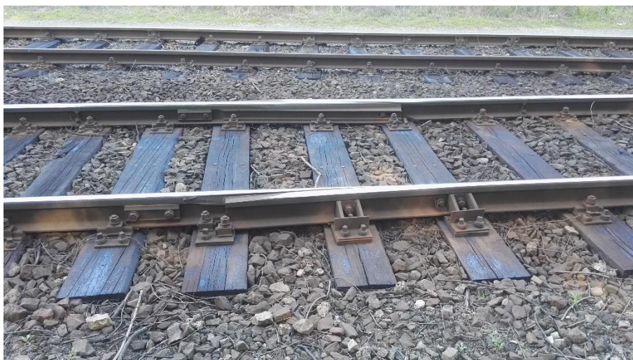
Obrázek 9: Dilatační zařízení (zdroj: autor)
