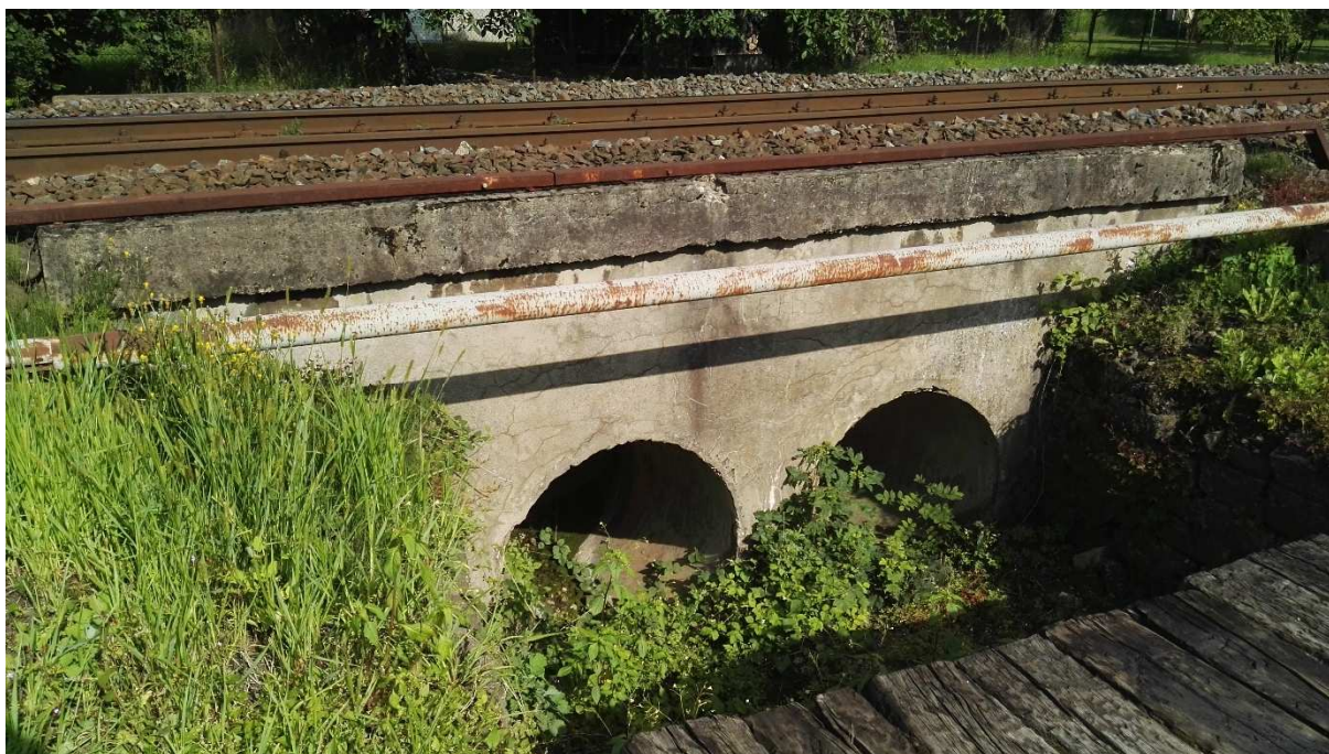
Obr. 9: Propustek s dvěma betonovými troubami (zdroj: autor)
