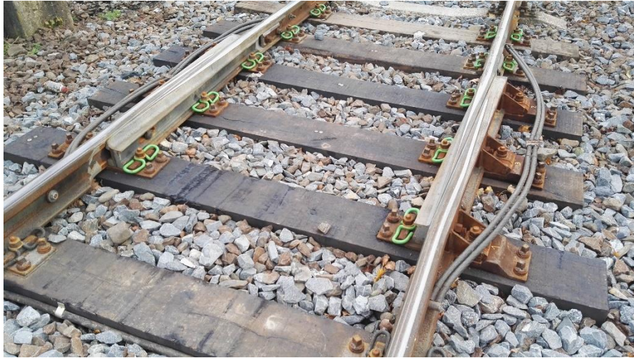
Obrázek 3: Mostní dilatační zařízení žst. Frýdek-Místek (zdroj: autor)
