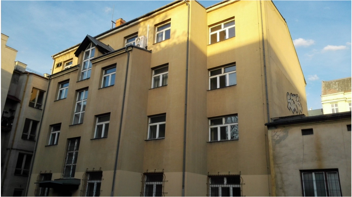
Pohled na stávající objekt blokové zástavby
