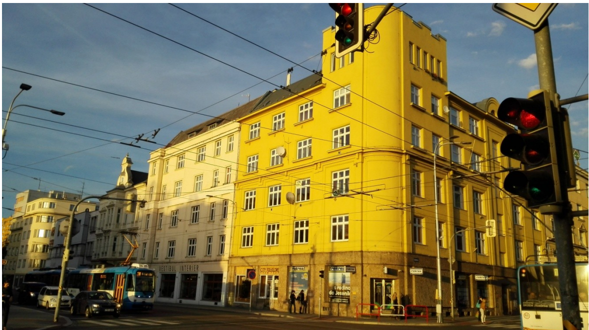
Pohled na okolní zástavbu řešeného území a ulici Nádražní
