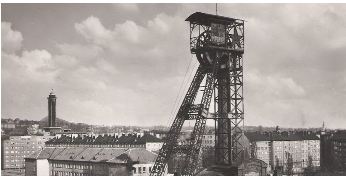
Obr. 5 Fotografie těžní věže Důl Jindřich [10]
