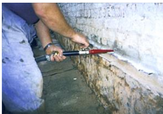
Obrázek 23 vyplnění drážky maltou [48]
