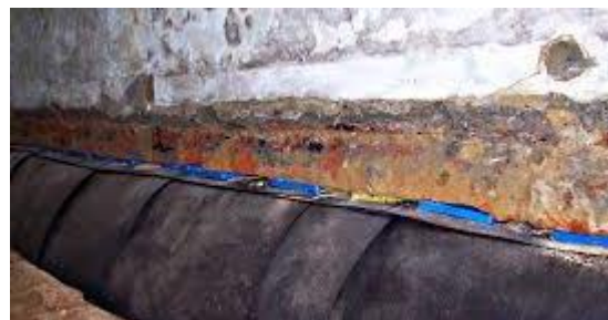
Obrázek 20 vložení izolace a statických klínů [50]
