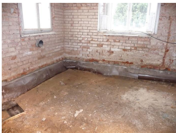
Obrázek 14 Připravenost pro podřezání [48]
