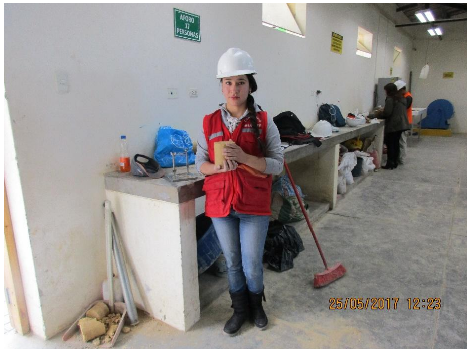
Imagen 28. Realización del ensayo de Proctor Modificado.
