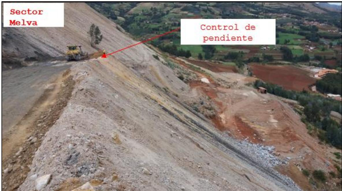
*Figura 16.* Control de pendiente en la mina Los Andes Perú Gold.
