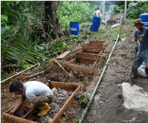
Figura 22a. Melhoria do solo da fundação.
