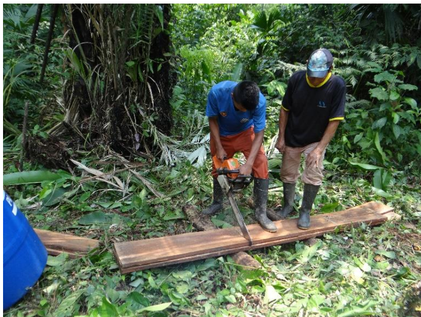
Figura 21b. Construção das formas
