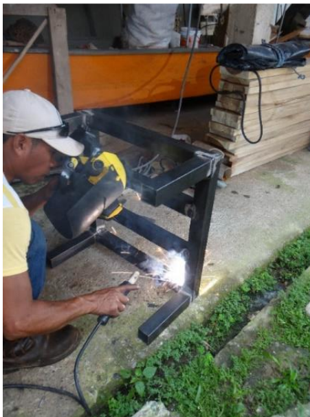
Figura 18. Construção dos suportes das bases dos tanques de PVC
