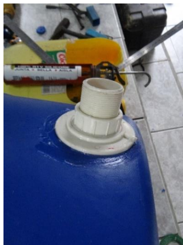
Figura 19b. Instalação dos acessórios
