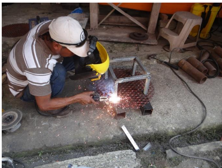
Figura 23. Construção da base de apoio do leito filtrante dos filtros.
