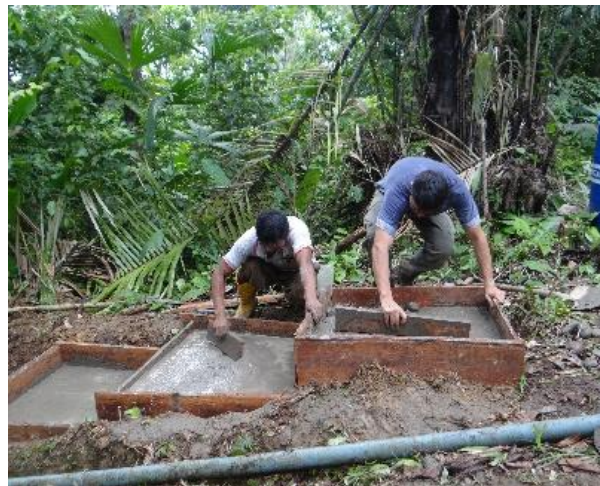
Figura 22d. Concretagem e nivelamento das lajes de fundação
