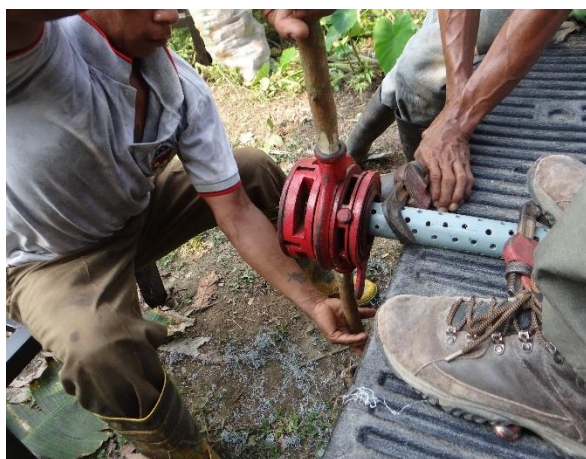
Figura 24b. Construção da rosca na tubulação com a entalha.
