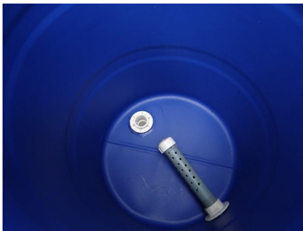
Figura 24c. Instalação da entrada da água no filtro.
