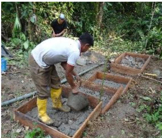
Figura 22c. Regularização da fundação com concreto magro
