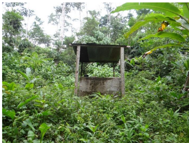
Figura 8. Reservatório do sistema de distribuição
