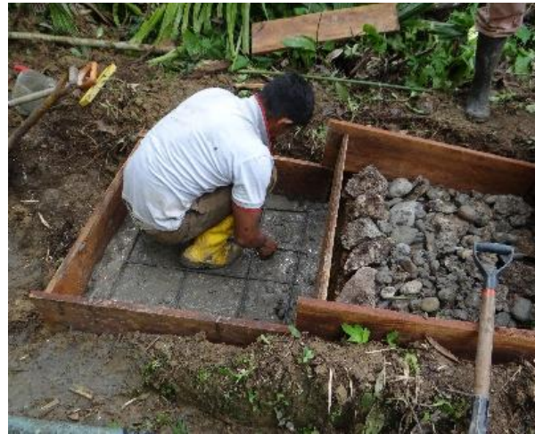
Figura 22b. Colocação da armadura nas lajes da fundação
