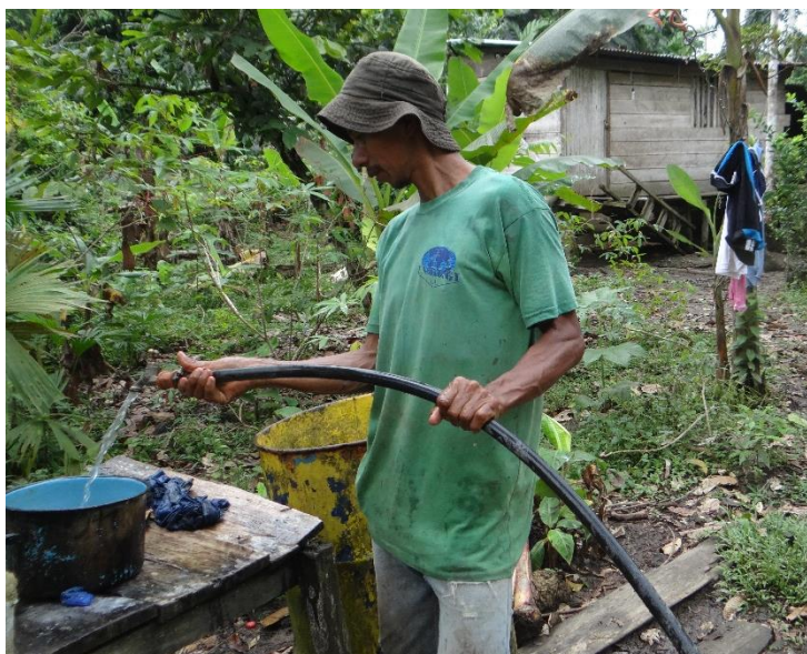
Figura 32. Verificação da vazão no último ponto do sistema de distribuição.
