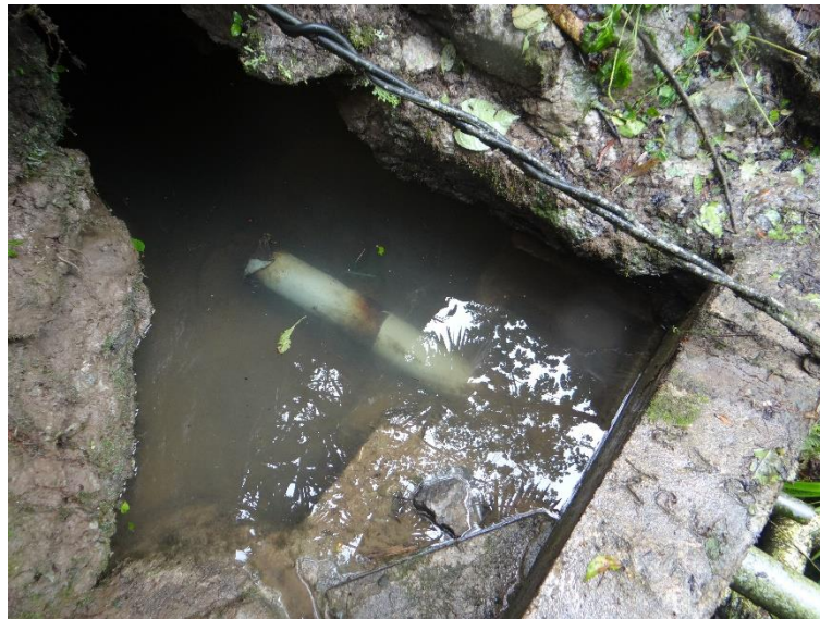
Figura 7. Ponto de captação do sistema de abastecimento.
