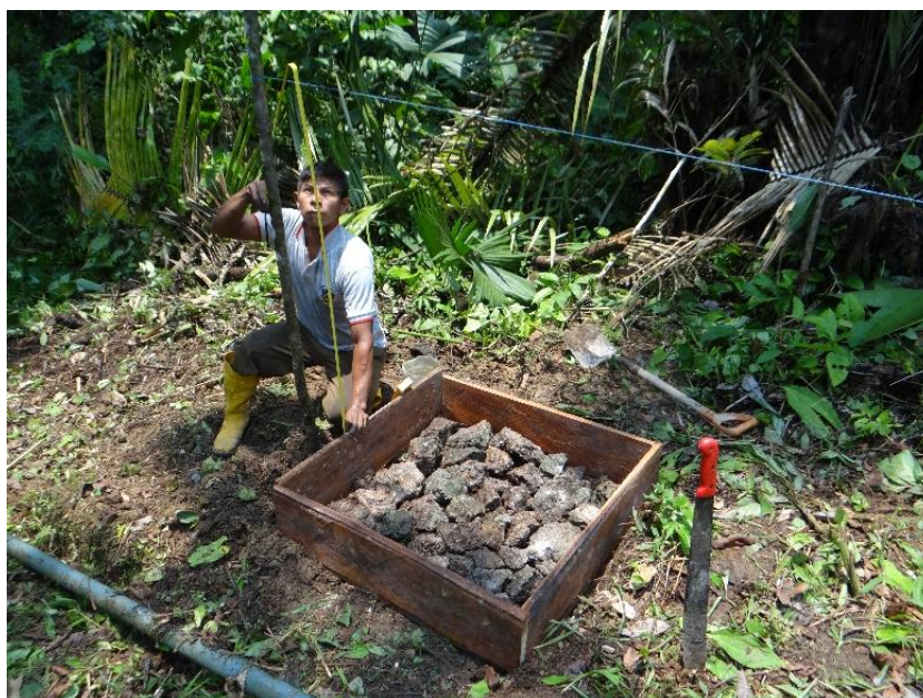
Figura 21c. Execução do gabarito da obra
