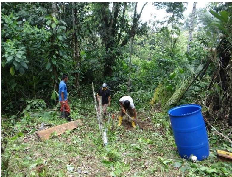
Figura 21a. Limpeza e desmatamento do terreno
