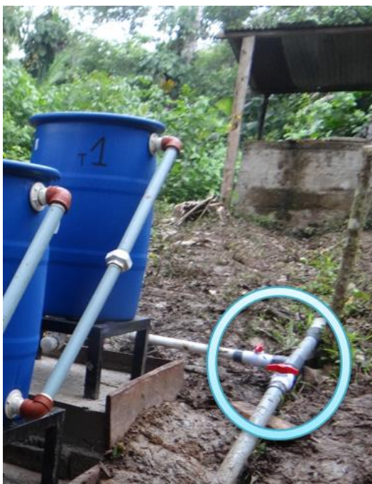
Figura 30. By-pass de limpeza do sistema de filtragem
