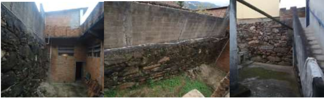
Figuras 06, 07 e 08: Estruturas da mineração no bairro do São Cristóvão em Ouro Preto - Mundéus.
