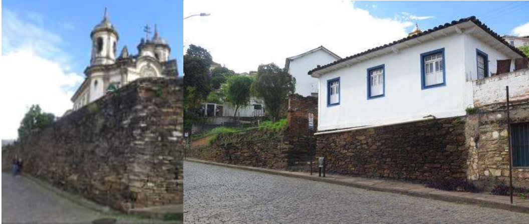
Figuras 12 e 13: Muro em pedra do adro da Igreja de São Francisco de Assis e embasamento de casa, Ouro Preto/MG.
