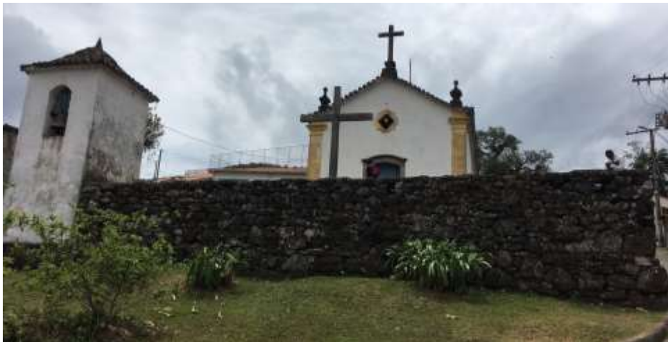
Figura 14: Muro em pedra no adro da Capela de Santana, Ouro Preto/MG.
