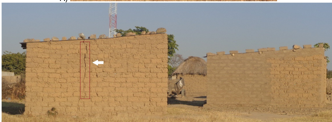
Figura 1. Construção em terra crua amplamente praticada na província da Huíla: A) Casas de adobe em Kaluquembe, construídas no século passado; B) Ilustração de algumas patologias estruturais nas habitações: degradação por fissuração.
