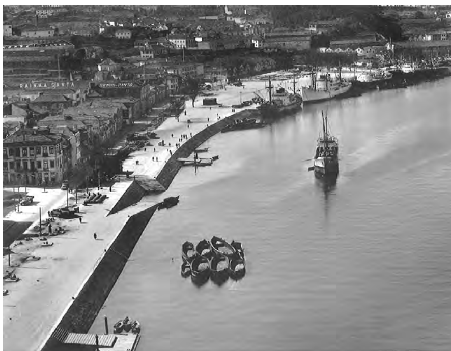
FIGURA 2 • CAIS DE GAIA
