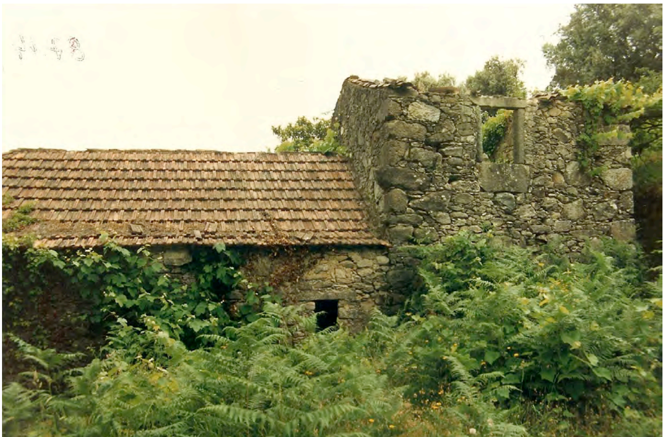
FOTO EXTERIOR. EXISTENTE
