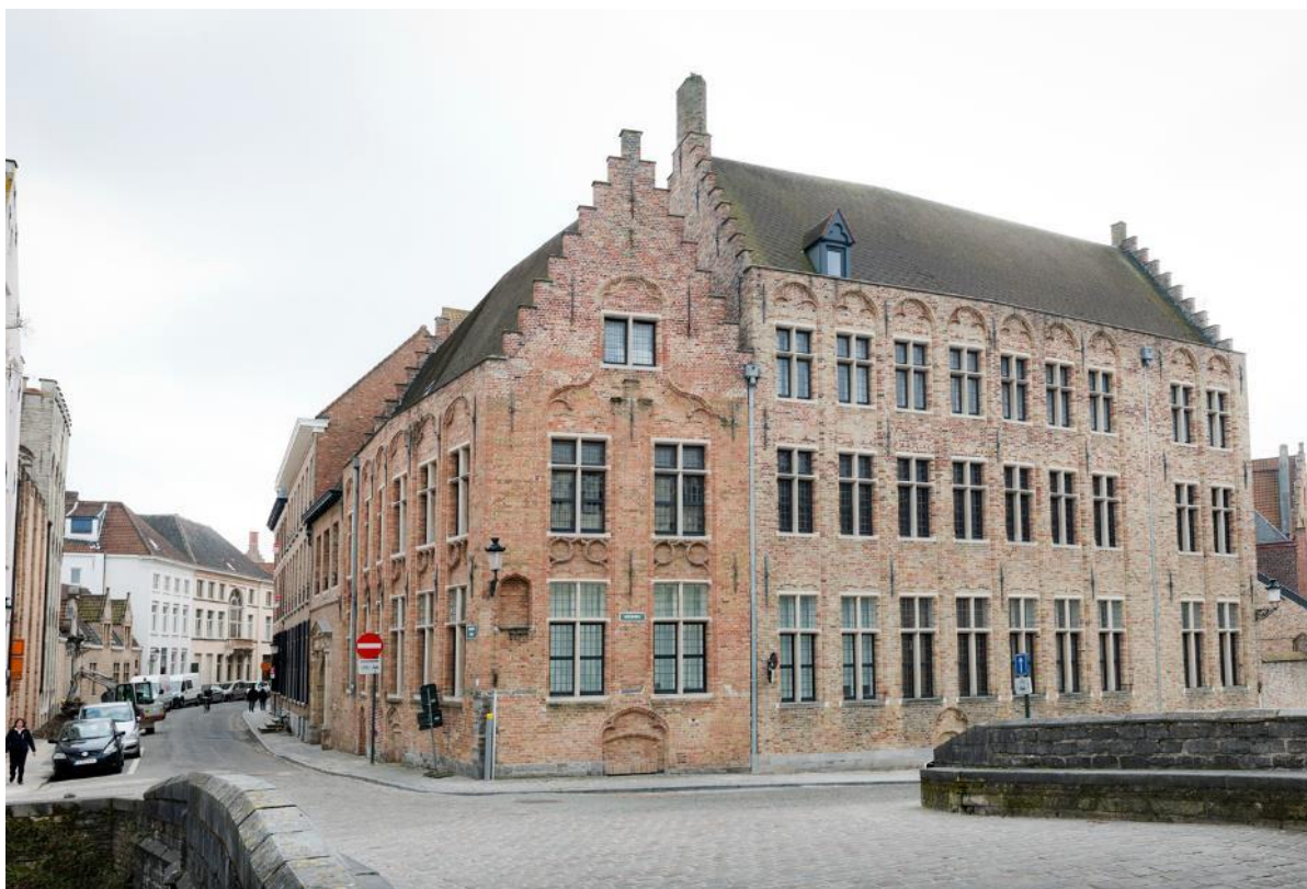
Foto 17: Object 12615 46 Huis Den Noodt Gods of Spookhuis: gevels en bedaking, Spanjaardstraat 17, Brugge. In 1970 gesloopt met uitzondering van de gevel aan de Spanjaardstraat en de topgevel aan de Korte Winkel. Beschermd in 1974. (Bron: https://inventaris.onroerendergoed.be/erfgoedobjecten/29746/beelden © Thomas Verfaillie)
