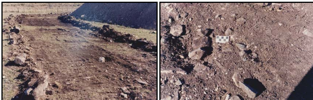
Camino construido sobre la ladera
