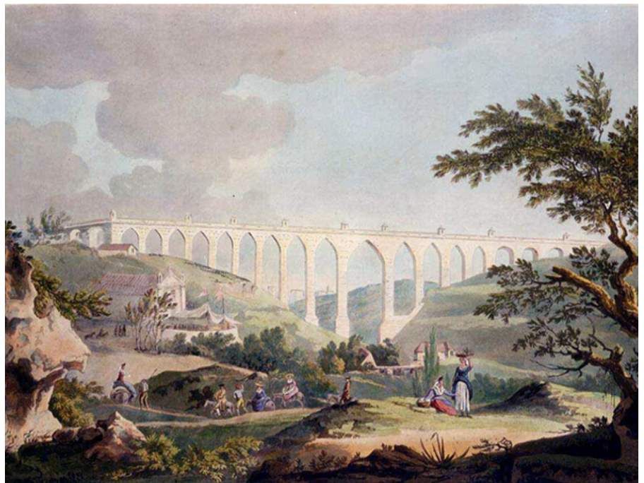
Fig. 3.05. "O aqueduto das águas livres do Vale de Alcântara", Séc. XVIII
