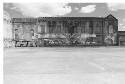
Fig. 3.17. Fachada da fábrica pelo interior do quarteirão, 2017
