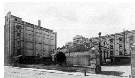
Fig. 3.21. Vista geral da fábrica
