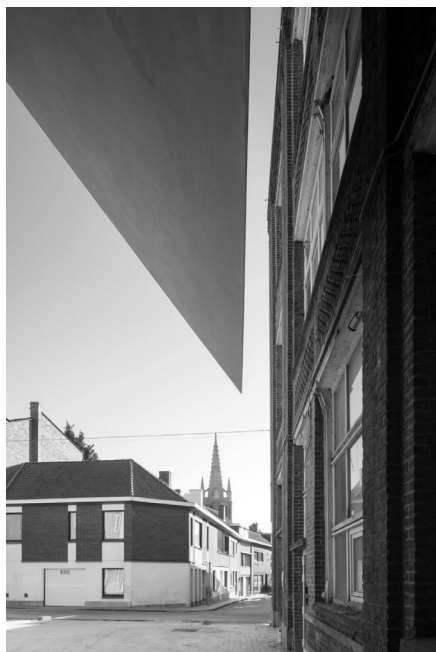
Fig. 4.13. Detalhe entre o novo e antigo
