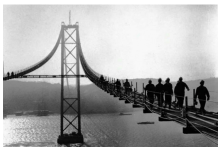
Fig. 3.14. Construção dos pilares da Ponte de Salazar
