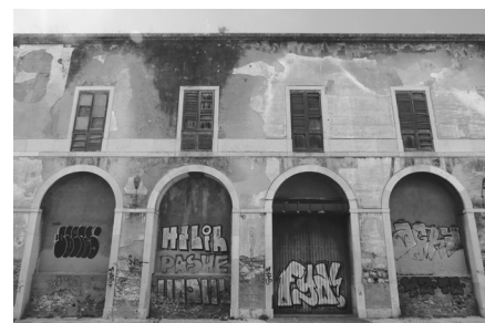
Fig. 3.18. Fachada da fábrica de Lanifícios de Bernardo Daupiás, 2017
