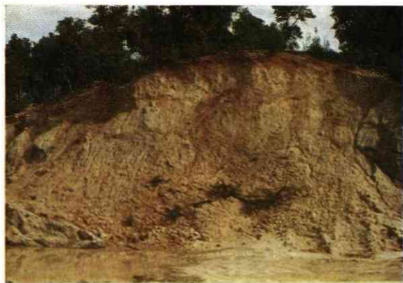
Fot. 5 — Aspecto geral do corte no Tojal. Quartzodiorito totalmente arenizado. O topo do corte contém depósito e está ferruginizado
