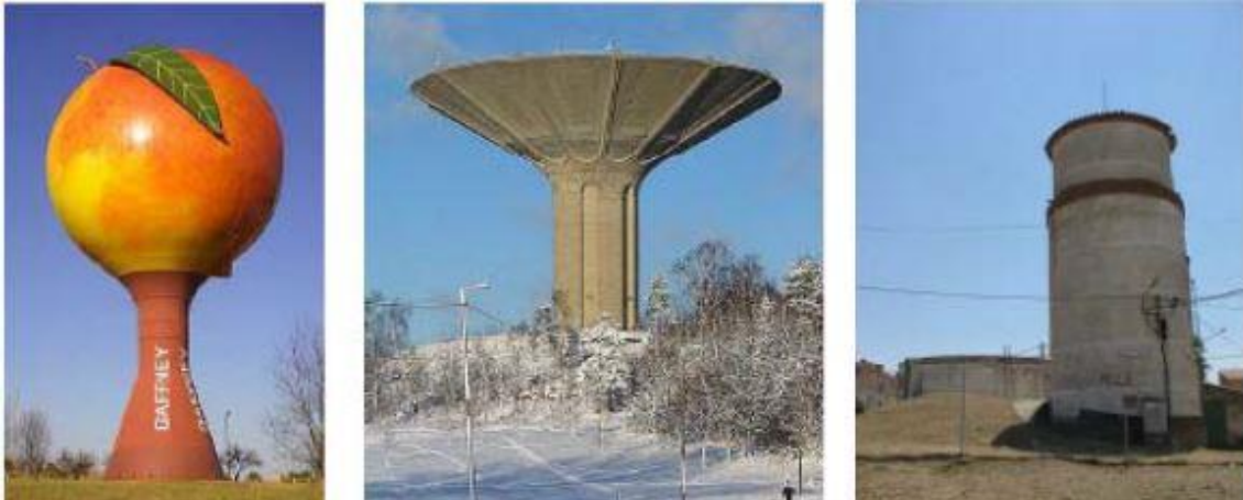
Figura 11 - Depósitos elevados Fuente: Navarro and Prieto, 2011
