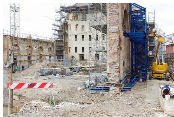
Fig. 3 Foto del cantiere di ricostruzione durante le fasi della traslazione del muro originario del teatro per la costruzione delle fondazioni. (Archivio Comune di Rimini)
