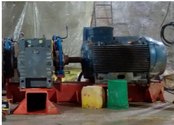
Ilustración 2. Conjunto motor-reductor en proceso de instalación en cuarto de máquinas 3860
