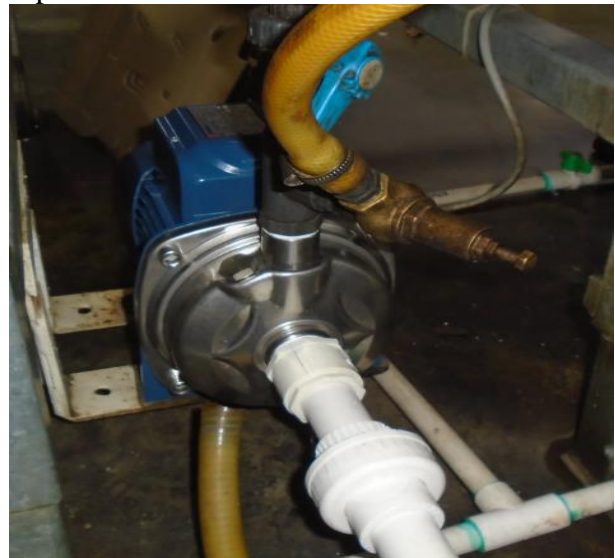
Figura 10. Nueva bomba del sistema de aspersión.
